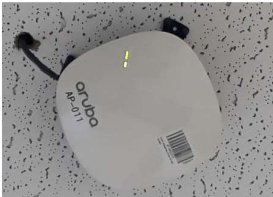
Fot. 1: Widok punktu dostępowego model Aruba Instant On AP11
