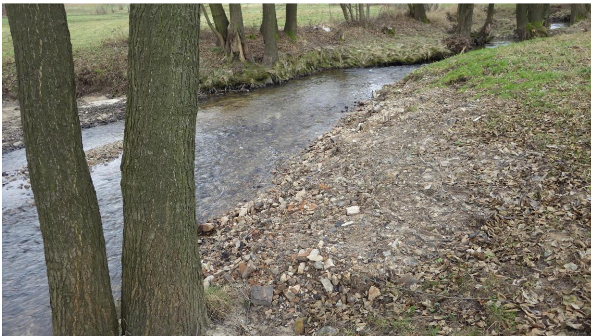
Fot. 2.8 Zasypanie wyrwy w brzegu materiałem rodzimym z koryta (Działanie 5.2). Fot. I. Biedroń
