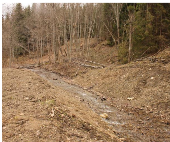
Miejsce po rozebraniu przepusku
