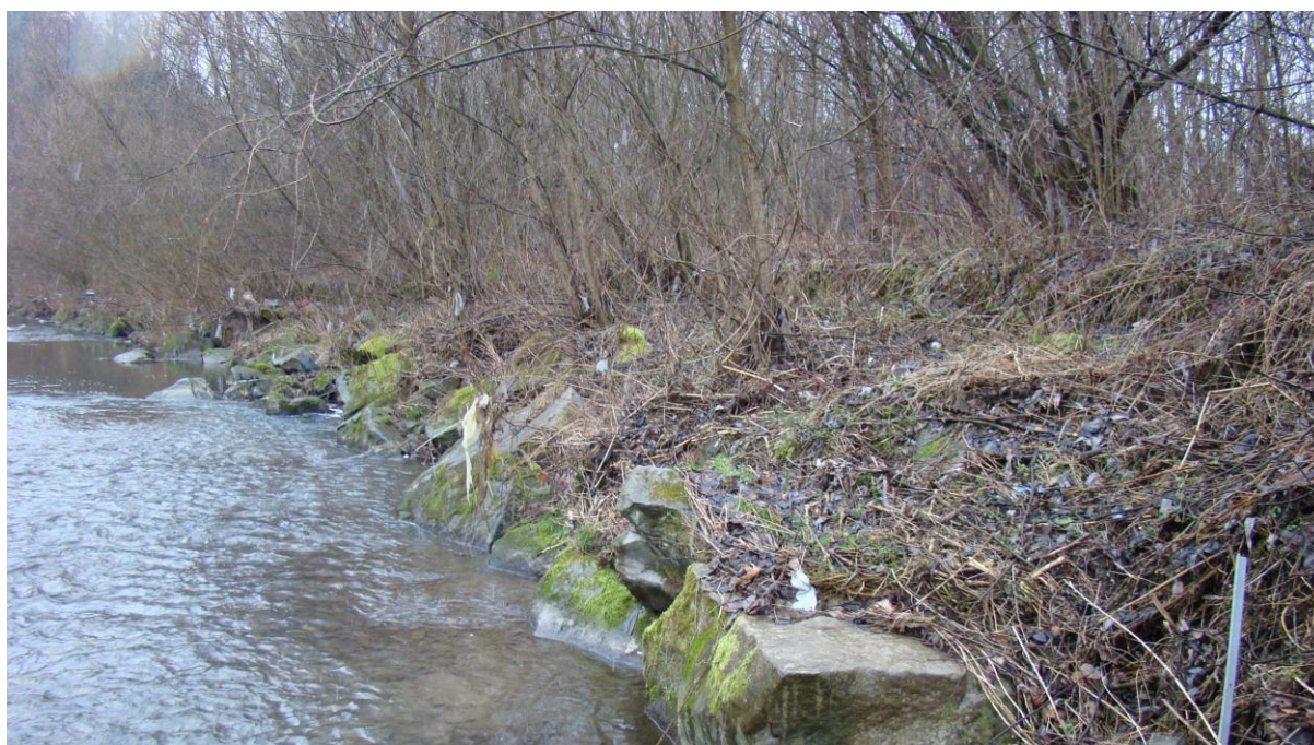
Fot. 1.2 Ubezpieczenie brzegu potoku górskiego z narzutu kamiennego porośnięte roślinnością kilkanaście lat po wykonaniu inwestycji. Fot. K. Wybraniec
