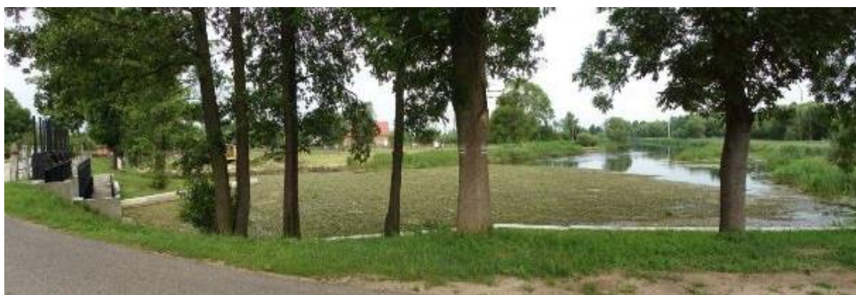
Fot. 7.10 Zator powstały z naniesionych przez wodę, nieusuniętych po wykoszeniu części roślin powyżej jazu. Fot. M. Grygoruk.
