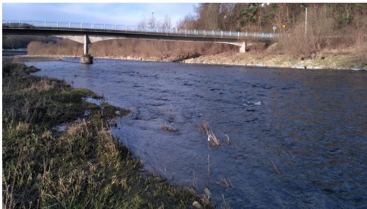
Fot. 2.7 Częściowe zasypanie wyrw w dnie podmywających filary mostu, osiągnięte przez uformowanie sekwencji bystrzy żwirowo-kamiennych i uruchomienie części żwirów odłożonych w wyższych częściach dorzecza. Forma wykonania Działania 5.1. Fot. I. Biedroń
