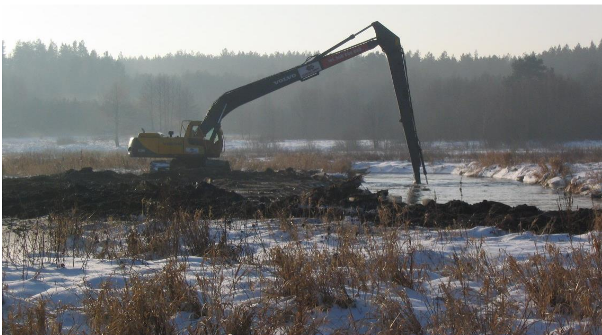
Fot. 2.9 Usuwanie namulów (Działanie 6.2). Fot. M. Grygoruk
