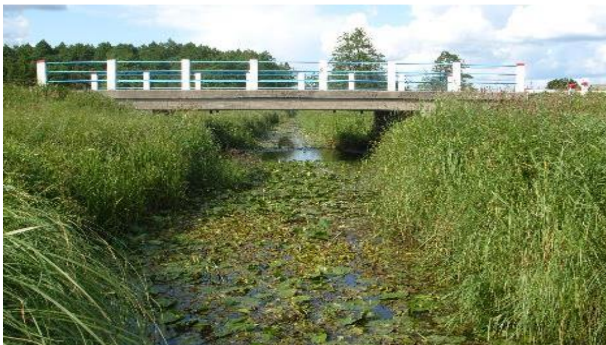
Fot. 7.4 Nadmiernie rozwinięta roślinność korytowa w niewielkiej rzece nizinnej w krajobrazie rolniczym. Pod mostem brak roślinności w wyniku zacienienia koryta. Fot. M. Grygoruk
