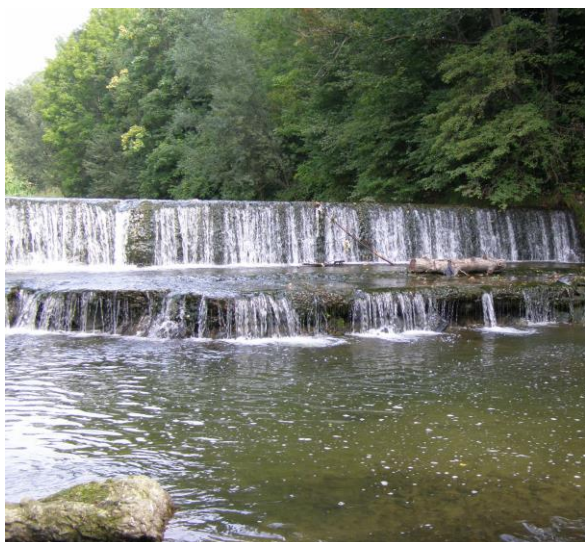
Stan przed przebudową
