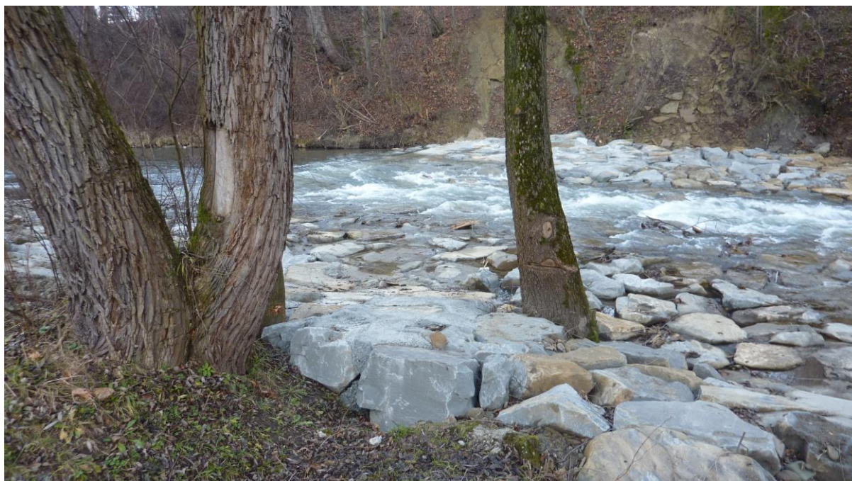
Fot. 1.1 Przypora jazu w postaci bystrza kamiennego wykonana w ramach usunięcia nieprawidłowości stanu technicznego. Źródło: archiwum RZGW w Krakowie
