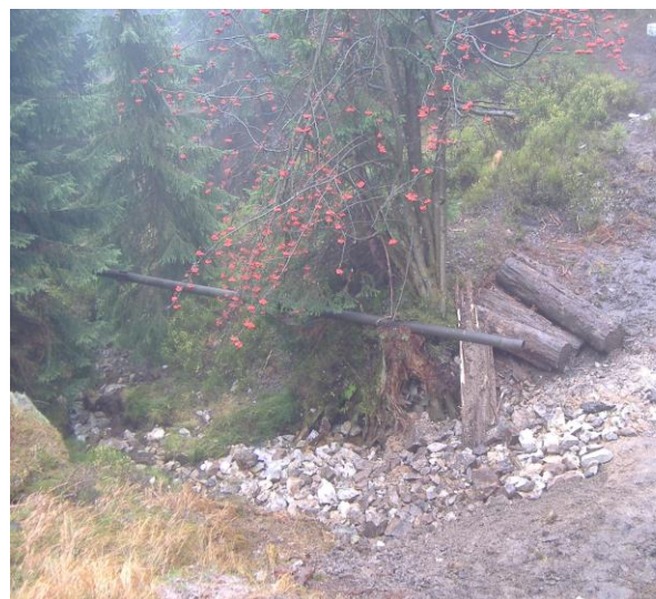
Stan po rozbiórkę
