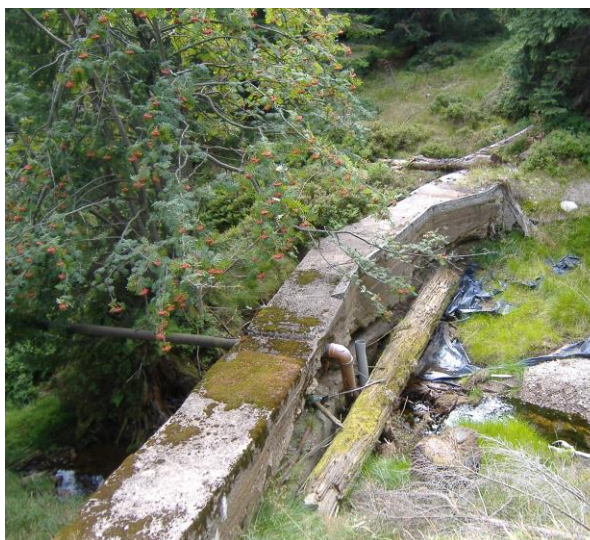
Stan przed rozbiórką
