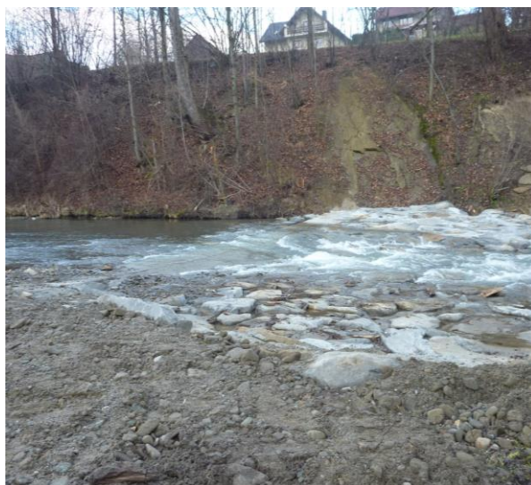
Stan po przebudowie
