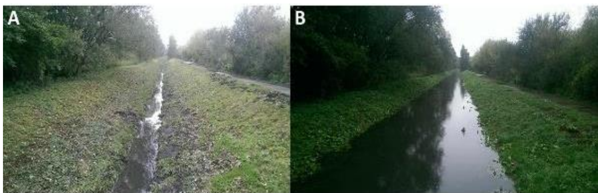
Fot. 7.2 Regularnie koszona roślinność brzegowa niewielkiego uregulowanego cieku w krajobrazie miejskim pozwala na utrzymanie wysokiej drożności wyższych poziomów koryta prowadzącego wody szybkich i krótkotrwałych wezbrań opadowych. A – niski stan wody; B – wysoki stan wody. Fot. M. Grygoruk
