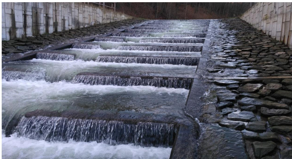
Fot. 7.13 Przebudowana zapora przeciwrumowiskowa, drożna dla ryb przy różnych stanach wody oraz częściowo drożna dla rumowiska rzecznego. Rozłożenie spadku na kilka stopni sprawia, że są one możliwe do pokonania dla ryb. Ukształtowanie przelewów zapewnia drożność także przy niskich stanach wody, a szerokie światło i brzegi ukształtowane w technologii grouted rock przeprowadzają przepływy wysokie i dają możliwość migracji organizmów wodnych w szczelinach między kamieniami. Fot. I. Biedroń
