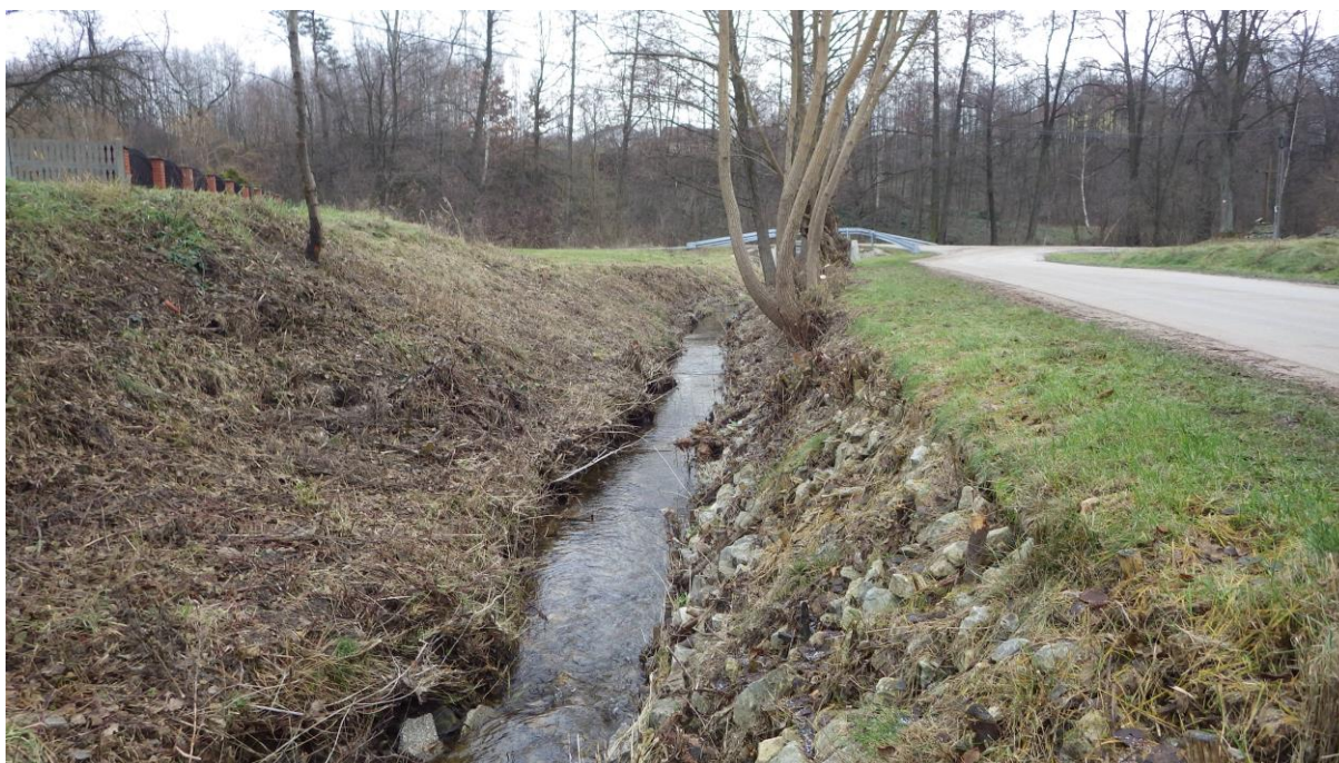
Fot. 2.1 Wykaszane brzegi ciek (Działanie 1.1) przeprowadzanego przez gorset infrastruktury. Fot. I. Biedroń
