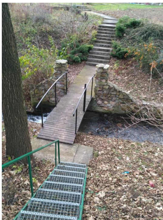
Fot. 2.5 Nieuzgodniona z właścicielem ciek, niska i źle pomyślana (zatorogenne barierki) kładka, choć niegroźna przy obecnym stanie wody, może stanowić przeszkodę dla wyższych przepływów i miejsce zatorogenne zagrażające sąsiedniej zabudowie. Może stanowić przeszkodę antropogeniczną wymagającą usunięcia w ramach Działania 4.2. Fot. I. Biedroń
