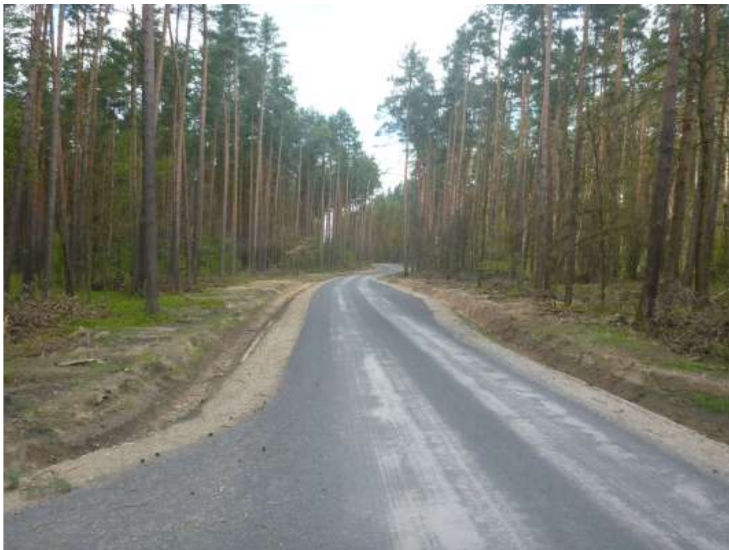
ZMODERNIZOWANA DROGA W LES. KARCZEWISKA (FOTO J. LISZCZYK)
