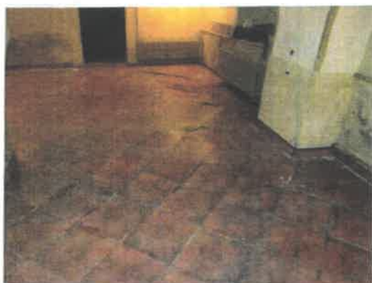
świetlica w przyziemiu
