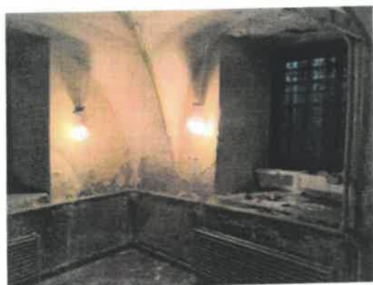
świetlica w przyziemiu
