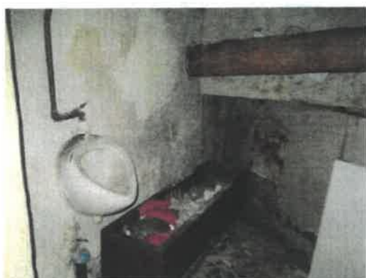
świetlica w przyziemiu
