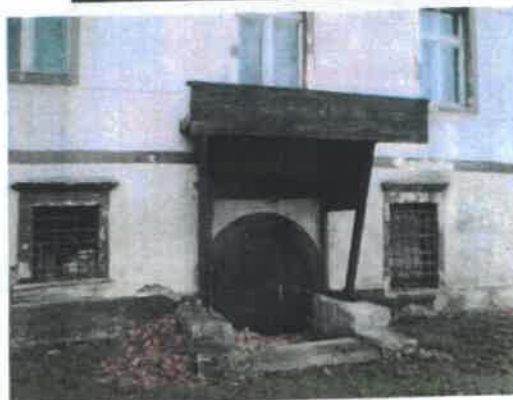
wejście do świetlicy w przyziemiu
