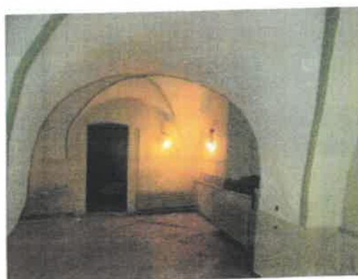
świetlica w przyziemiu
