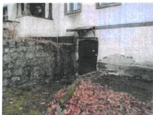
Wejście do piwnic
