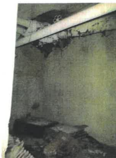
świetlica w przyziemiu
