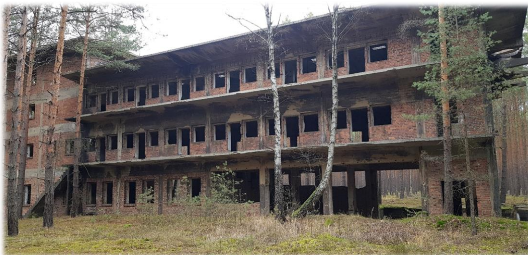
Fot. 37. Pozostałości po fabryce DAG (fot. M. Szneidrowski)
