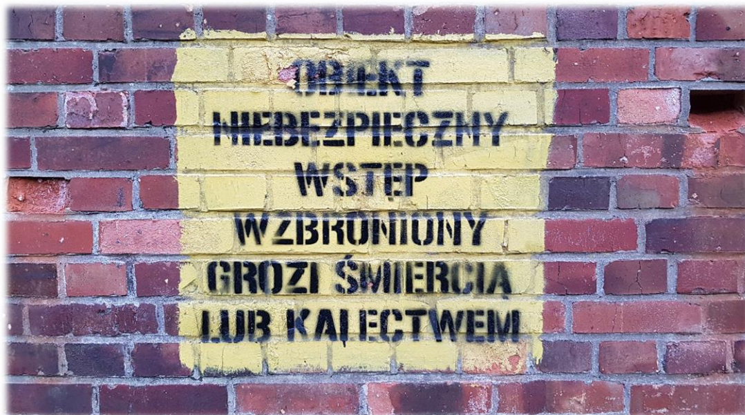
Fot. 39. Napis ostrzegający znajdujący się na jednym z budynków zespołu fabryki DAG (fot. M. Szneidrowski)
