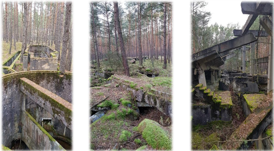
Fot. 38. Pozostałości po fabryce DAG (fot. M. Szneidrowski)
