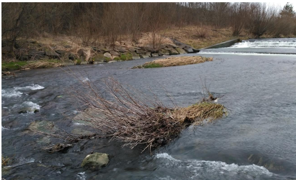
Fot. 12. Widok od strony bystrza na stopień w km 4+672 potoku Krzczonówka. Fot. I. Biedroń
