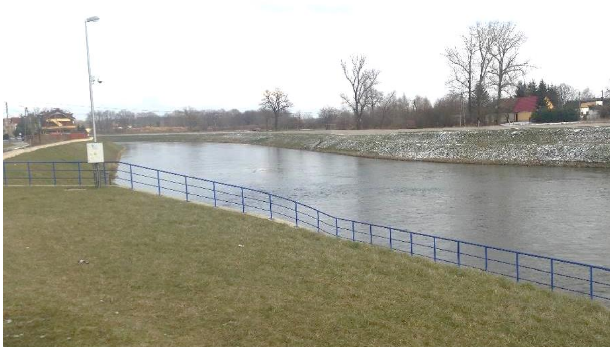
Fot. 14. Widok na rzekę w okolicy jazu stałego w km 61+256. Fot. M. Olszar
