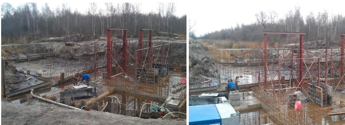
Fot. 10. Budowa jazu w korycie Kan. Woźnawiejskiego. Na czas budowy elementów konstrukcyjnych jazu wody kanału skierowano do koryta okrążającego plac budowy, przy zachowaniu oszczędności wykorzystania terenu. Fot. M. Grygoruk
