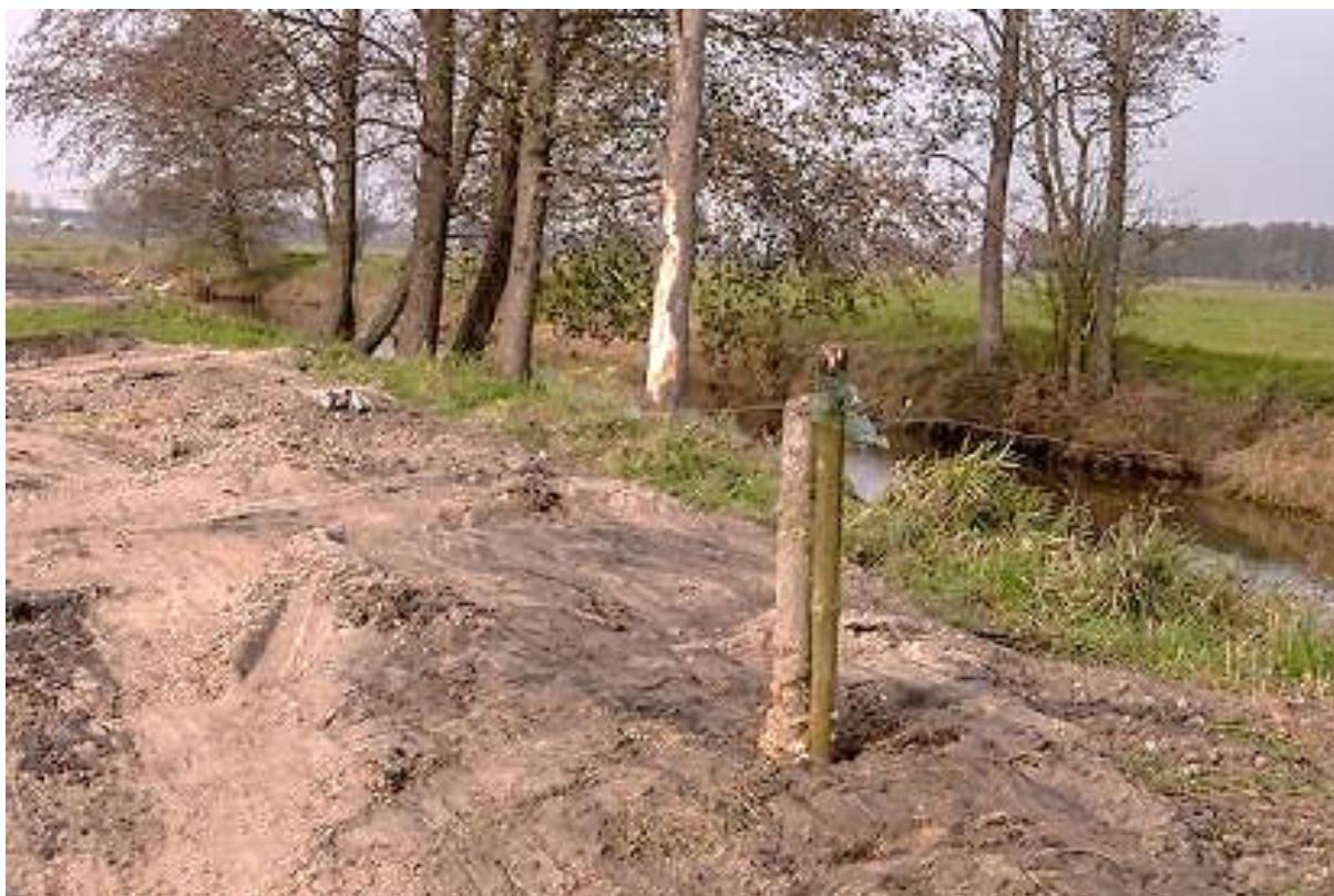
Fot. 2. Wydobycie z dna cieku urobek rozplantowano cienką warstwą na brzegu rzeki, z zachowaniem miejsc, w których plantowania nie prowadzono. Pozwala to na względne zachowanie łączności wód zalewowych z wodami rzeki. Fot. P. Fiedorczyk.
