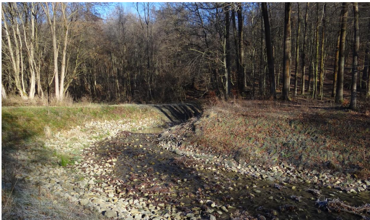
Fot. 24. Potok Hohubla w miejscu po rozebranych jazie i murze oporowym - bystrza o zwiększonej szorstkości wraz z umocnieniem brzegu poprzez narzut kamienny i nasadzenie palikowane. Fot. W. Pilch
