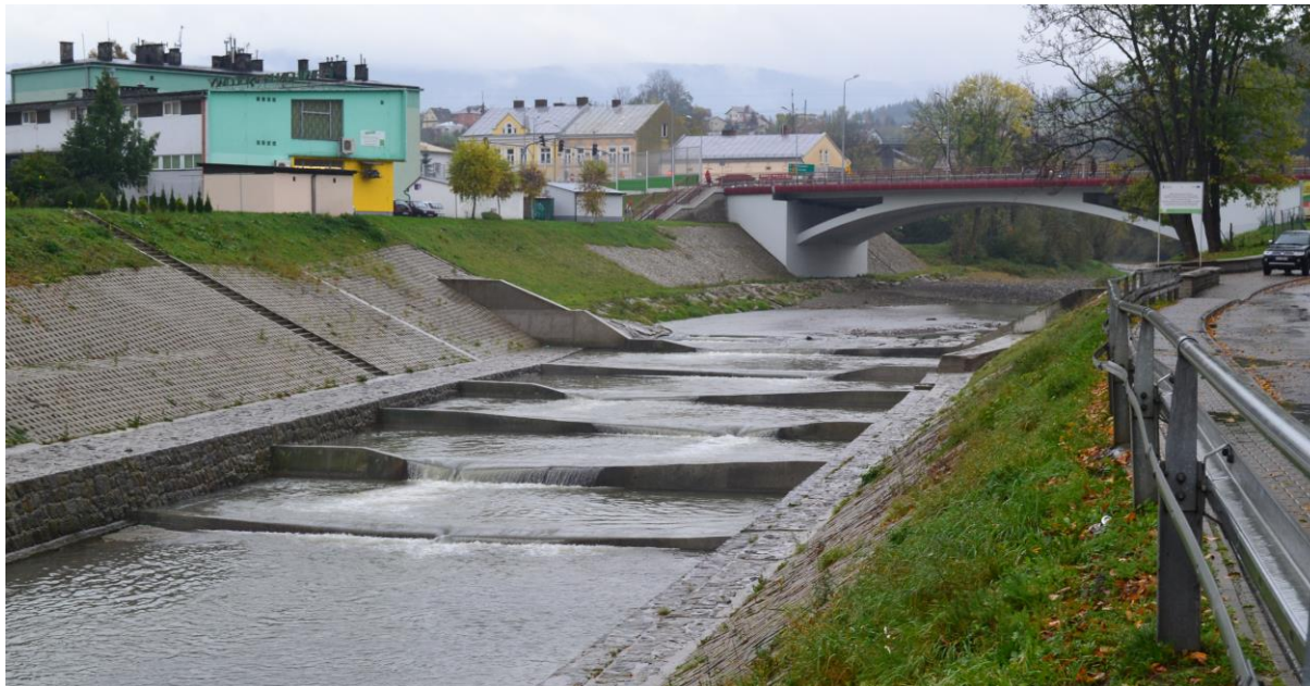
Fot. 20. Stopień na Białej w Grybowie – po modernizacji. Wysoki próg został zastąpiony kaskadą niższych stopni o nieregularnej koronie umożliwiającej zmiany rozkładu prędkości nurtu. Zmodernizowany stopień wodny nie stanowi bariery dla migrujących ryb. Źródło: archiwum RZGW w Krakowie
