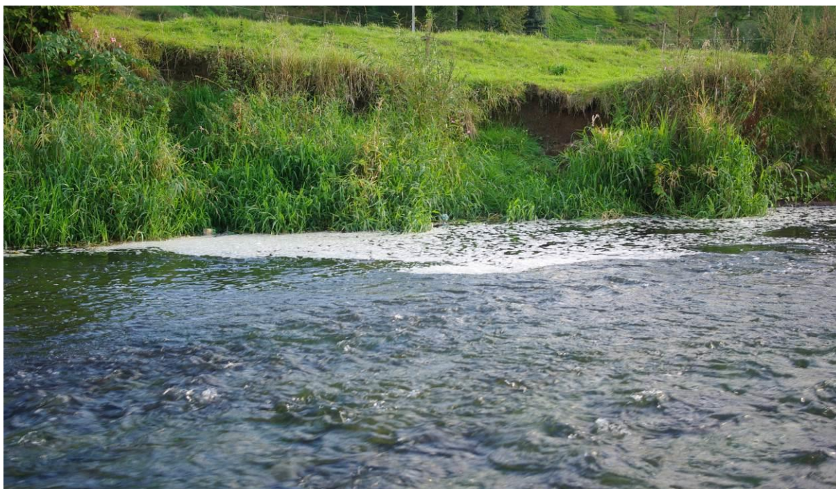
Fot. 16. Stabilne podcięcie brzegu niezagrożone nadmierną erozją boczną, utrwalone w wyniku dobrze zaplanowanych robót hydrotechnicznych. Źródło: Pietruczuk i in., 2017 - archiwum WWF Polska
