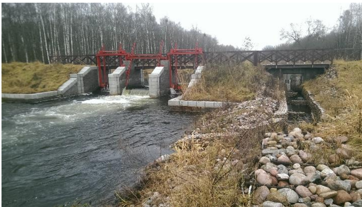
Fot. 11. Styl architektoniczny jazu nawiązuje do położonych w pobliżu zabytkowych budowli wodnych w Kan. Augustowskim. Fot. M. Grygoruk.
