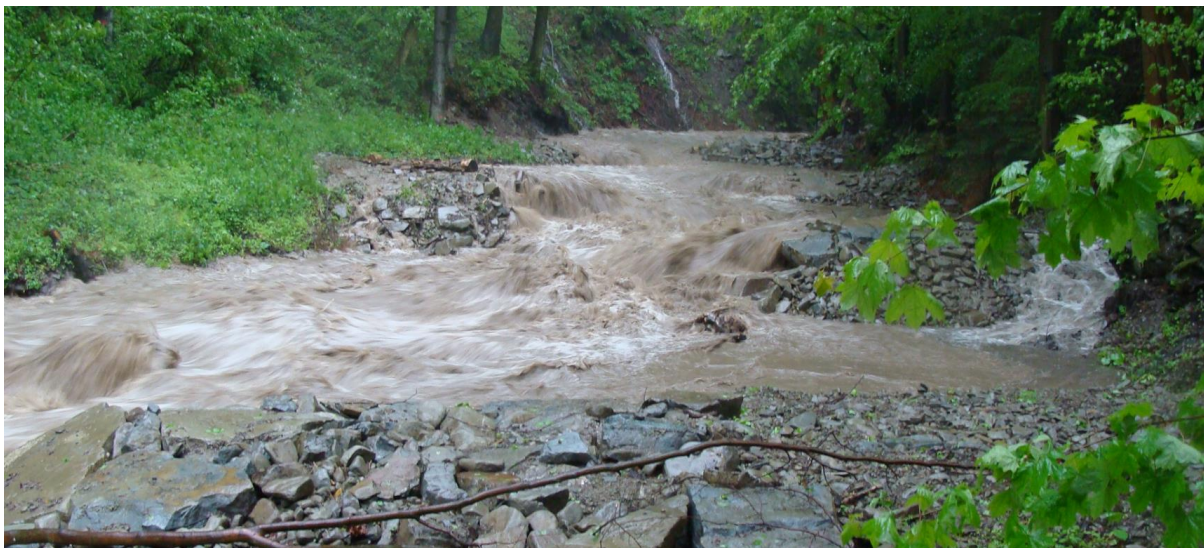
Fot. 18. Przeprowadzone roboty hydrotechniczne umożliwiły ograniczenie erozji bocznej i utrzymanie ciek w granicach wyznaczonego geodezyjnie koryta, nawet w warunkach wysokiego przepływu. Fot. A. Myśliwiec
