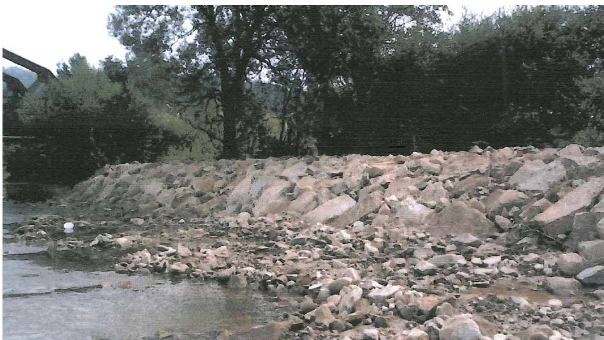
Fot. 8a. Brzeg prawy km 11+808 – 11+849. Rok 2005. Źródło: archiwum RZGW w Krakowie
