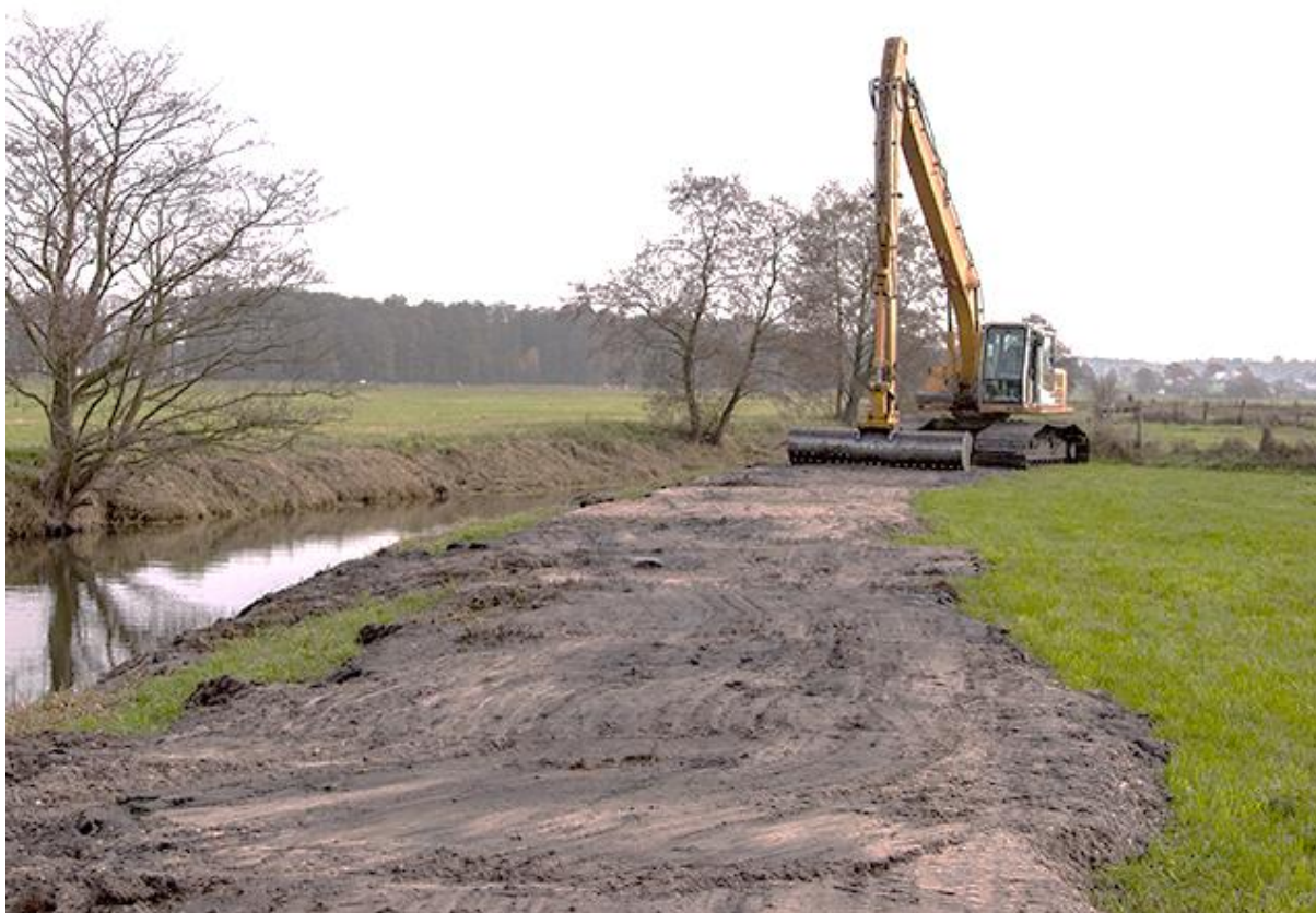
Fot. 1. Wydobyty z dna ciekłu urobek rozplantowano cienką warstwą na brzegu rzeki. Fot. P. Fiedorczyk
