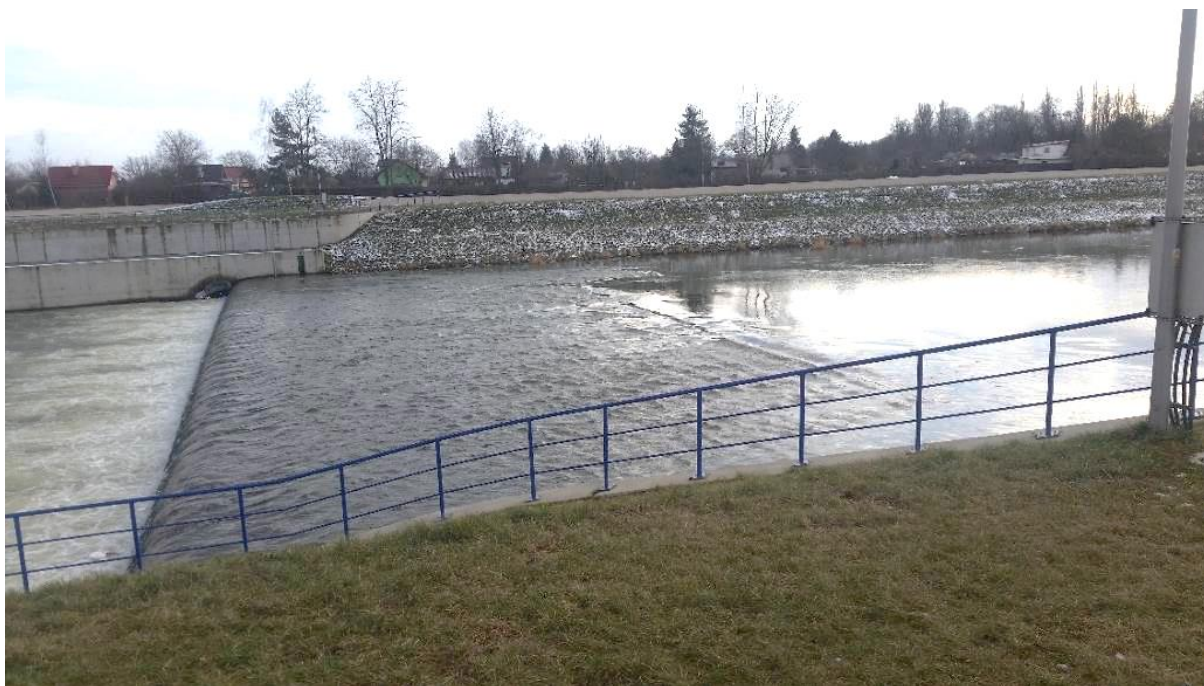
Fot. 13. Widok na jaz stały w km 61+256 - na zdjęciu widoczny murek przeciwpowodziowy oraz przebudowany jaz stały wraz przepławką dla ryb. Fot. M. Olszar
