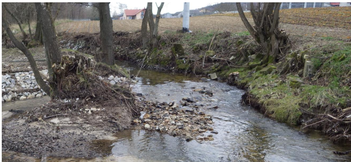
Fot. 5. Usuwając rumoszu mineralny (namuły) oraz zalegający w korycie rumoszu drzewny zachowano naturalnie ukształtowaną wyspę w korycie oraz odsyp żwirowy. Fot. I. Biedroń
