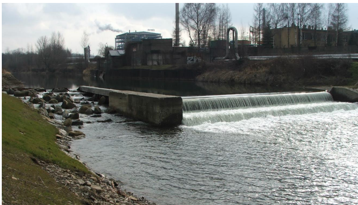
Fot. 22. Stopień na Wisłoce w km 107+200 w miejscowości Jasło po przebudowie. Udrożnienie bariery migracyjnej dla organizmów wodnych polegało na wykonaniu bystrotoku kaskadowego na prawym brzegu rzeki. Fot. P. Sobieszczyk
