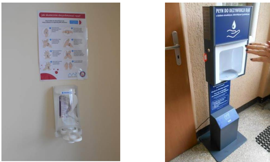
Rys. 5, 6 Zapewnienie prawidłowej dezynfekcji oraz higieny rąk.
