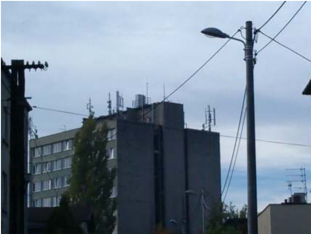
Fot. 3. Fragment instalacji radiokomunikacyjnej na dachu budynku przy ul. Medyków
