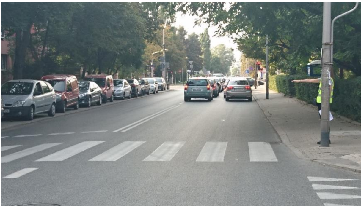
Rys. 6.5 Przykłady słupa ograniczającego widoczność przy przejściu dla pieszych – perspektywa kierowcy - powiększenie rys. 6.4
