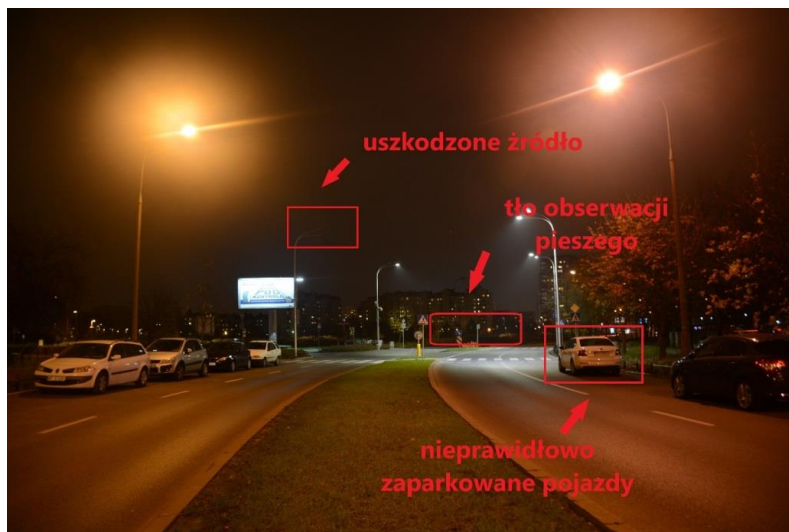
Rys. 8.21 Widok drogi z elementami mogącymi wpłynąć na nieprawidłową identyfikację klasy oświetlenia (obszar tła za przejściem, uszkodzone źródło światła, niewłaściwie zaparkowane pojazdy)
