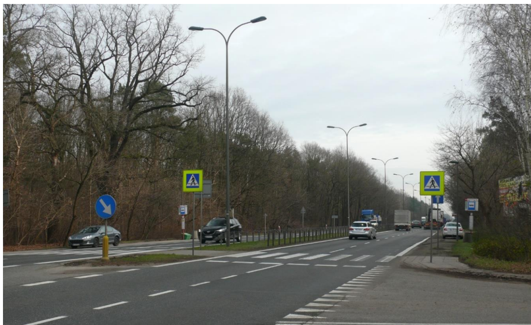
Rys. 3.72 Latarnie umieszczone w pasie dzielącym o szerokości mniejszej niż 6,0 m. Przejście dla pieszych na skrzyżowaniu
