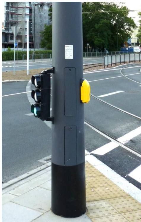
Rys. 6.54 Słup trakcyjno-sygnalizacyjno-oświetleniowy z wysięgnikiem a) widok ogólny, b) widok na oddzielne wnęki dla potrzeb sygnalizacji świetlnej i oświetlenia
