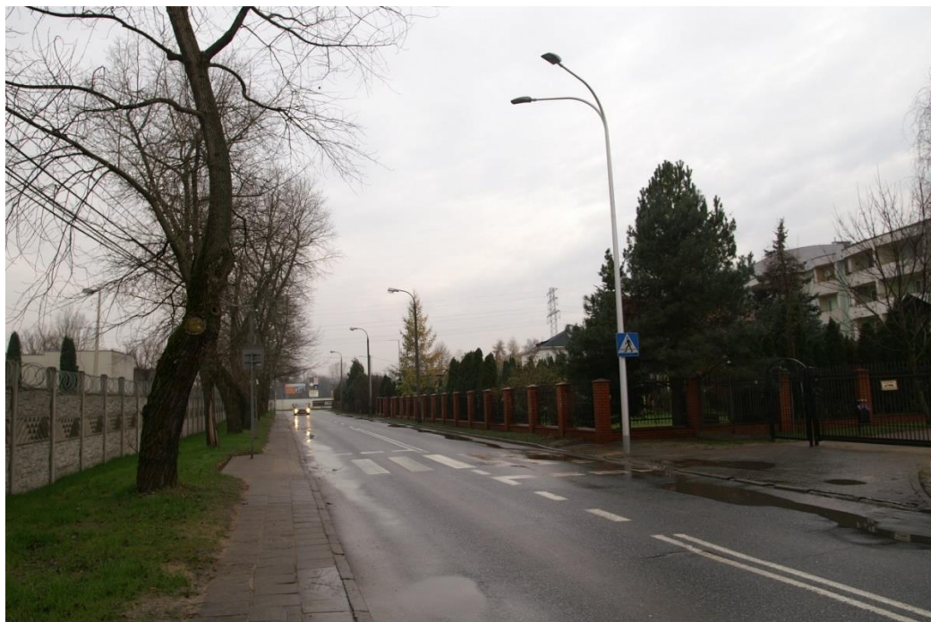
Rys. 3.57 Jednostronny system latarni. Dedykowane oświetlenie „Y” dla przejścia dla pieszych. Przejście dla pieszych poza skrzyżowaniem
