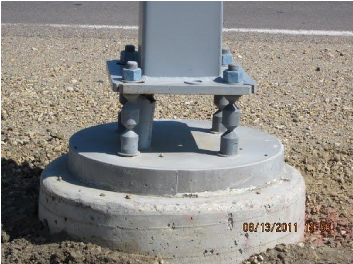
Rys. 6.2 Przykład fundamentu dla słupa NE
