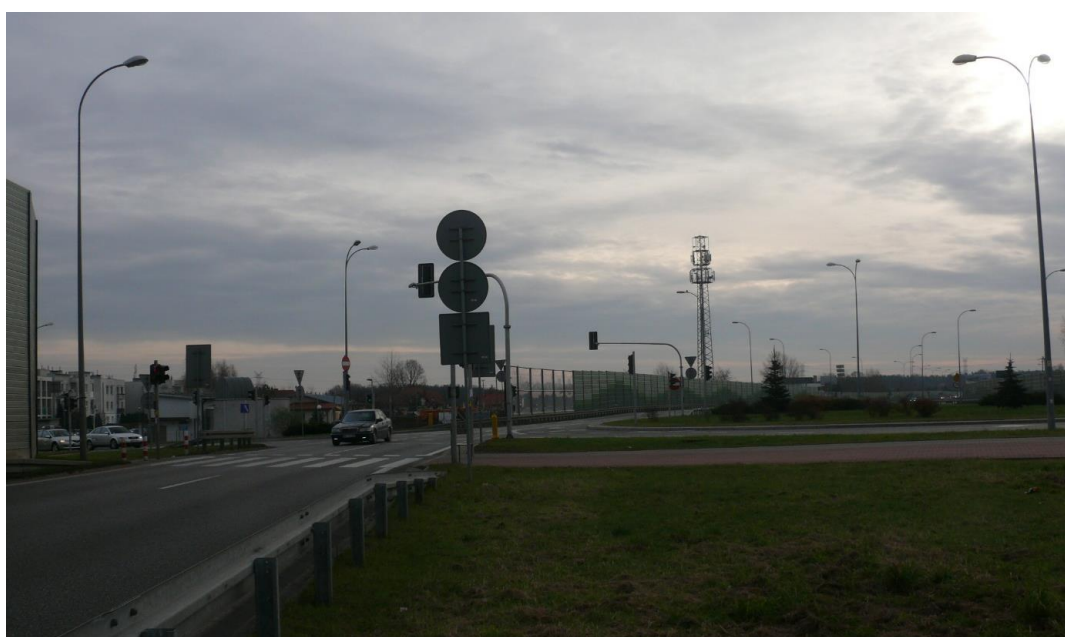
Rys. 3.67 System oświetlenia skrzyżowania z ruchem okrężnym po obszarze zabudowanym. Latarnie typu pojedynczy „V”. Przejście dla pieszych oświetlone pojedynczą oprawą
