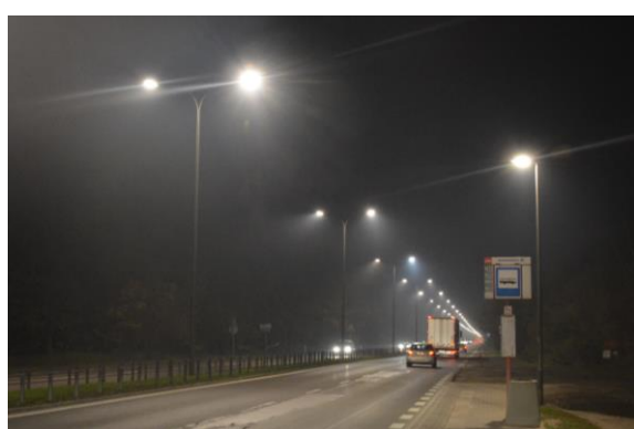
Rys. 3.12 System jednostronny w pasie dzielącym
