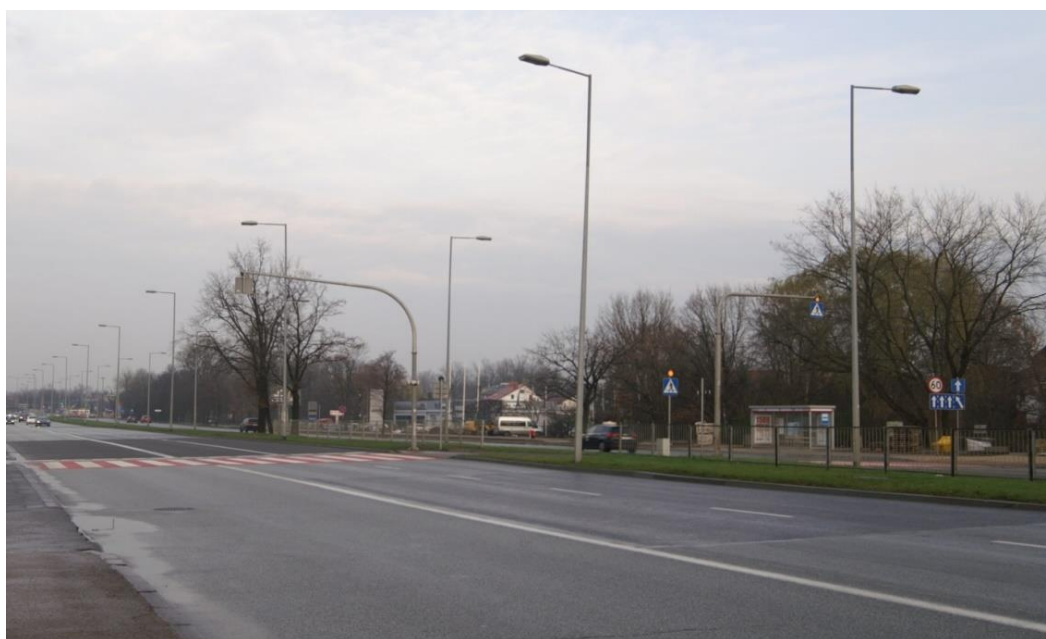
Rys. 3.55 System dwurzędowych latarni umieszczonych w pasie dzielącym przy lewych krawężniach jezdni. Przejście dla pieszych poza skrzyżowaniem
