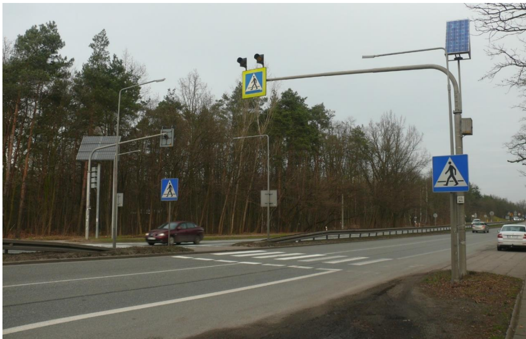
Rys. 3.69 Autonomiczny system oświetlenia przejścia dla pieszych z zastosowaniem dodatkowego znaku D-6 z pulsatorami
