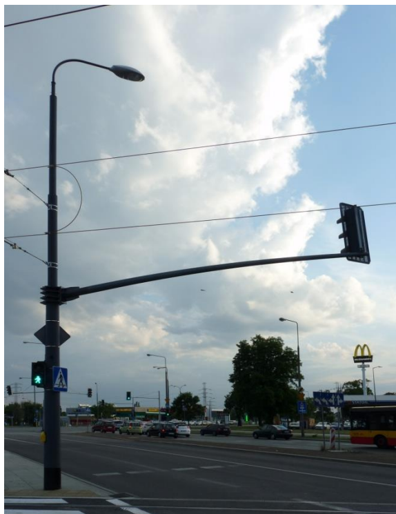
Rys. 6.54 Słup trakcyjno-sygnalizacyjno-oświetleniowy z wysięgnikiem a) widok ogólny, b) widok na oddzielne wnęki dla potrzeb sygnalizacji świetlnej i oświetlenia
