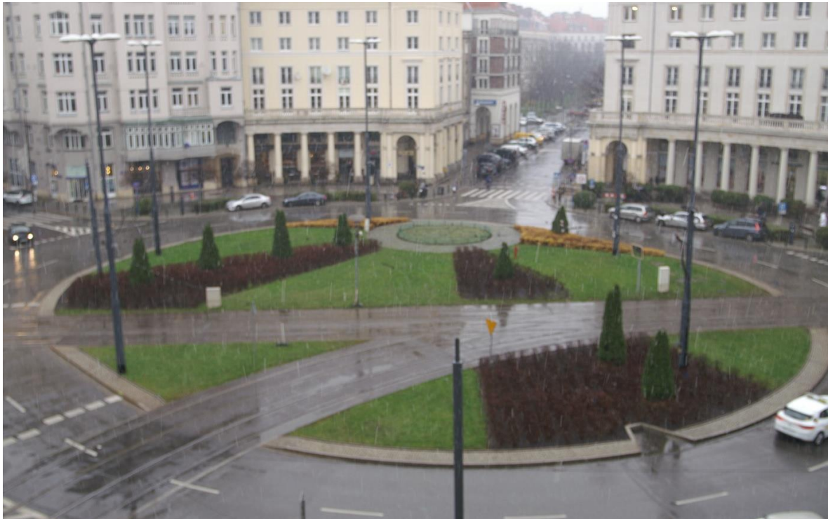
Rys. 3.63 Oświetlenie masztowe na skrzyżowaniu z ruchem okrężnym
