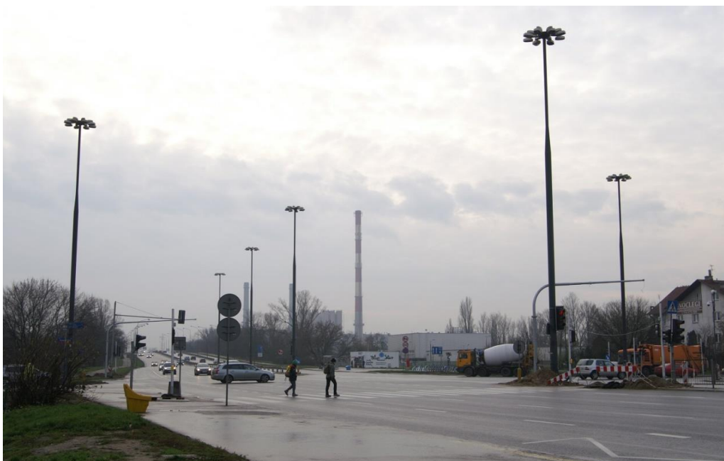
Rys. 3.59 Oświetlenie masztowe na skrzyżowaniu skanalizowanym. Przejście dla pieszych na skrzyżowaniu
