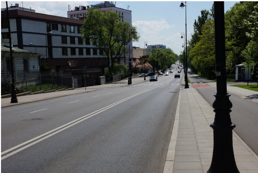
Rys. 3.53 Latarnie umieszczone obustronnie, naprzemiennie. Przejście dla pieszych poza skrzyżowaniem
