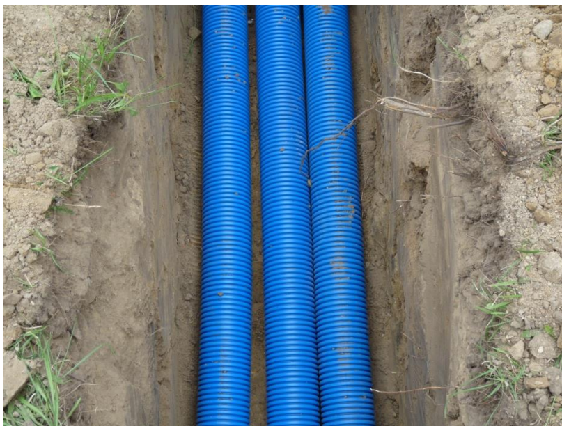
Rys. 6.55 Rury osłonowe karbowane średnicy 110 mm w wykopie przed zasypaniem
