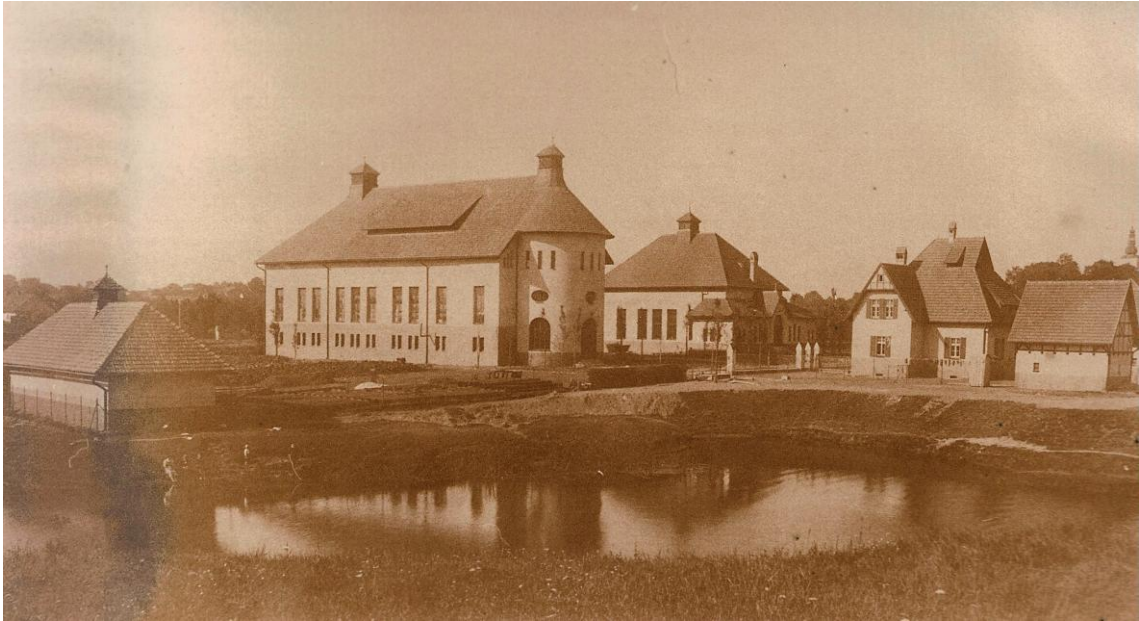
Rycina 4 Stacja Uzdatniania Wody Łabędy – kiedyś [źródło: http://pwik.gliwice.pl/stacja-uzdatniania-wody-w-gliwicach-labedach.html ]
