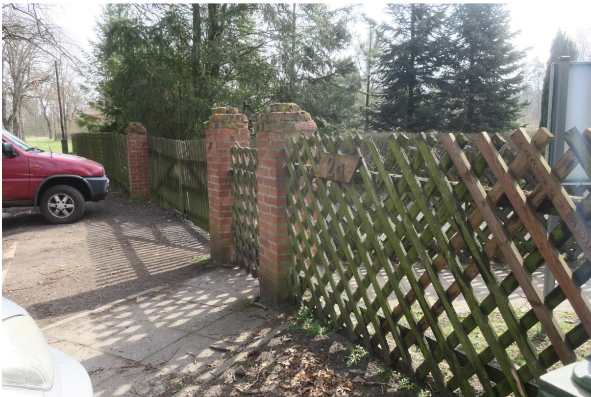
Fot. 3 – słupki murowane, brama i furтка do rozbiórki
