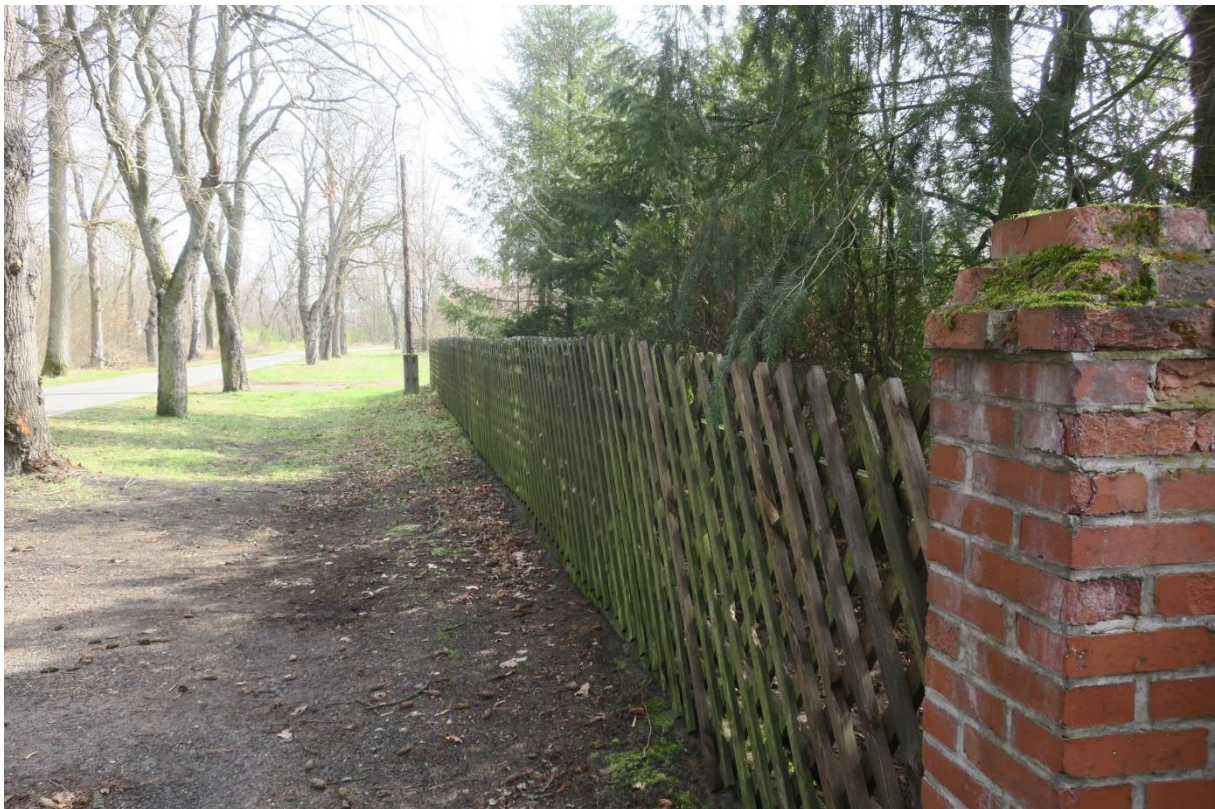
Fot. 5 – część ogrodzenia nie przeznaczona do rozbiórki, słupek ceglany do którego należy domontować nowe ogrodzenie
