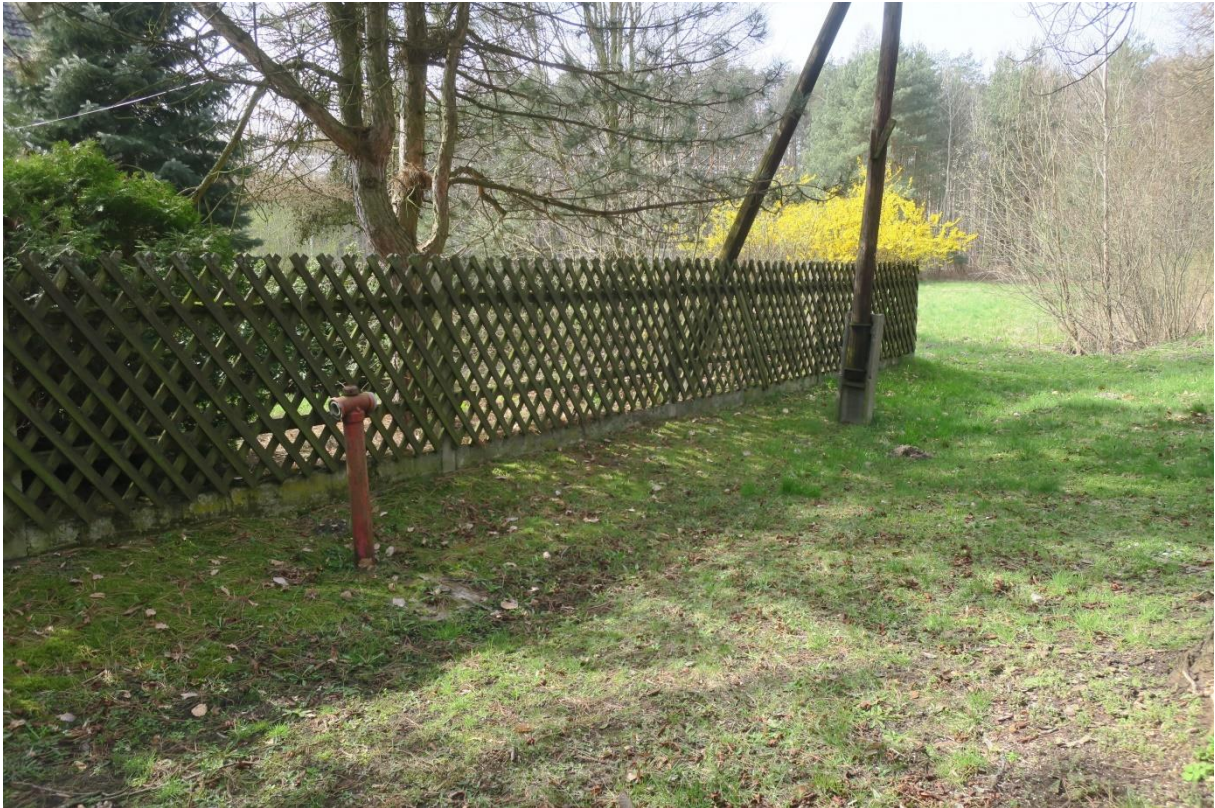
Fot. 1 – Ogrodzenie wraz z podmurówką do rozbiórki
