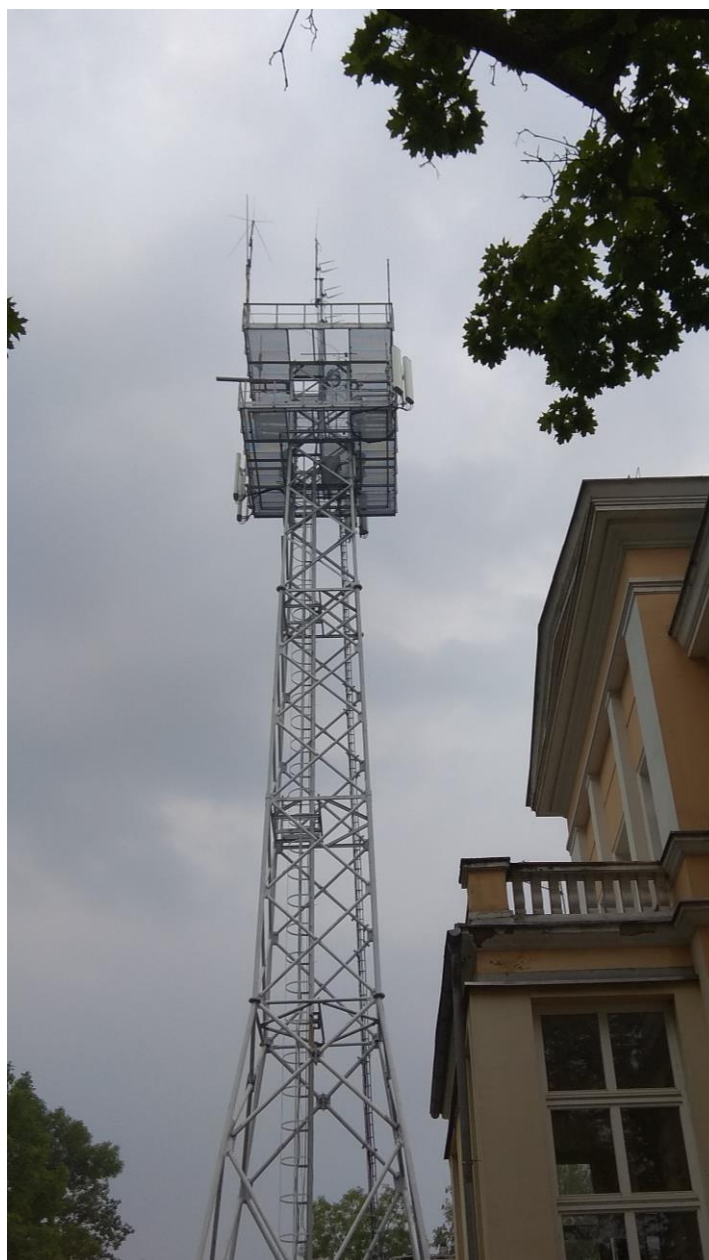
Fot. 1: Widok anten stacji bazowej ID: OPO1504_A, zlokalizowanej pod adresem: ul. Piastowska 20, 45-081 Opole
