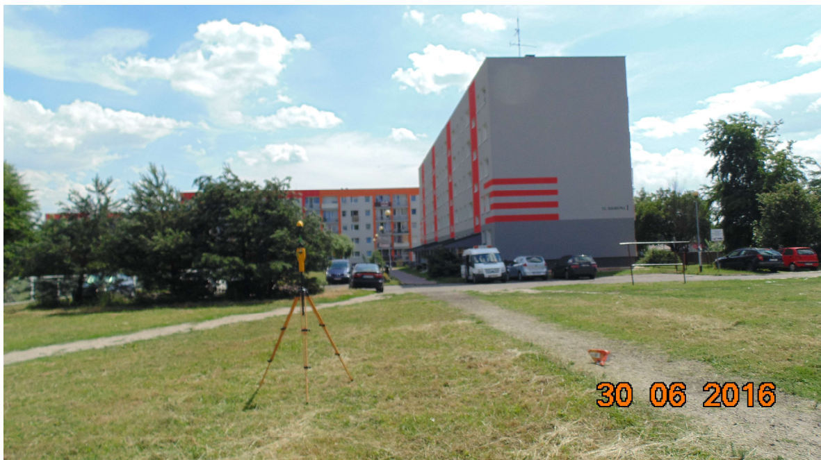
Fot. 2. Rejon badań, widok w kierunku wschodnim
