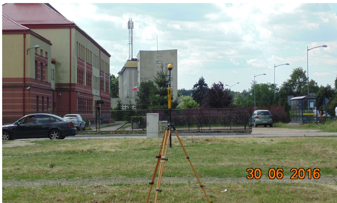
Fot. 3. Fragment instalacji radiokomunikacyjnych przy ul. Sienkiewicza
