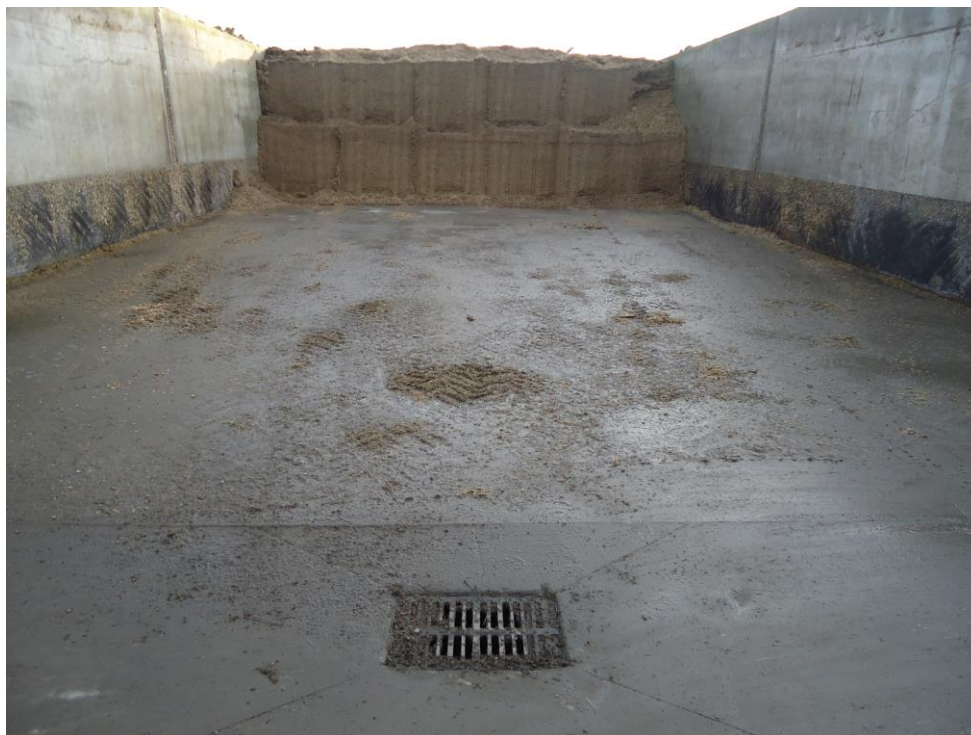
Fotografia 5. Wykonanie spadków płyty dennej silosu przejazdowego w celu odprowadzenia nadmiaru odcieków oraz wody opadowej
