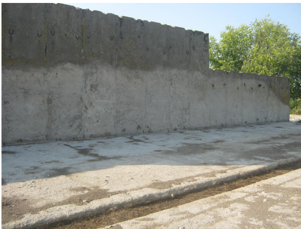
Fotografia 3. Silos betonowy do przechowywania kiszonek
