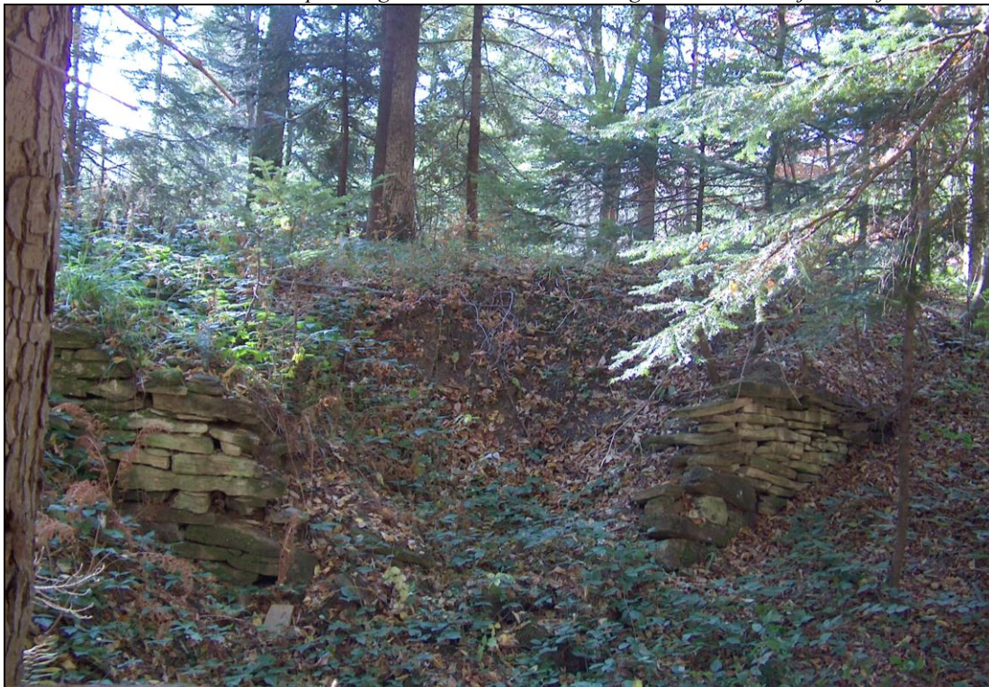
Pozostałości murku oporowego na trasie zlikwidowanego torowiska kolejki leśnej.
