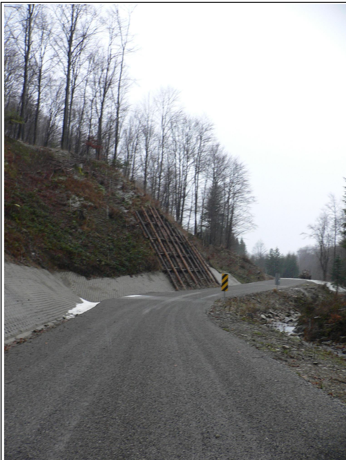
Fot. 5 Zabezpieczenie skarpy w leśnictwie Maniów.
