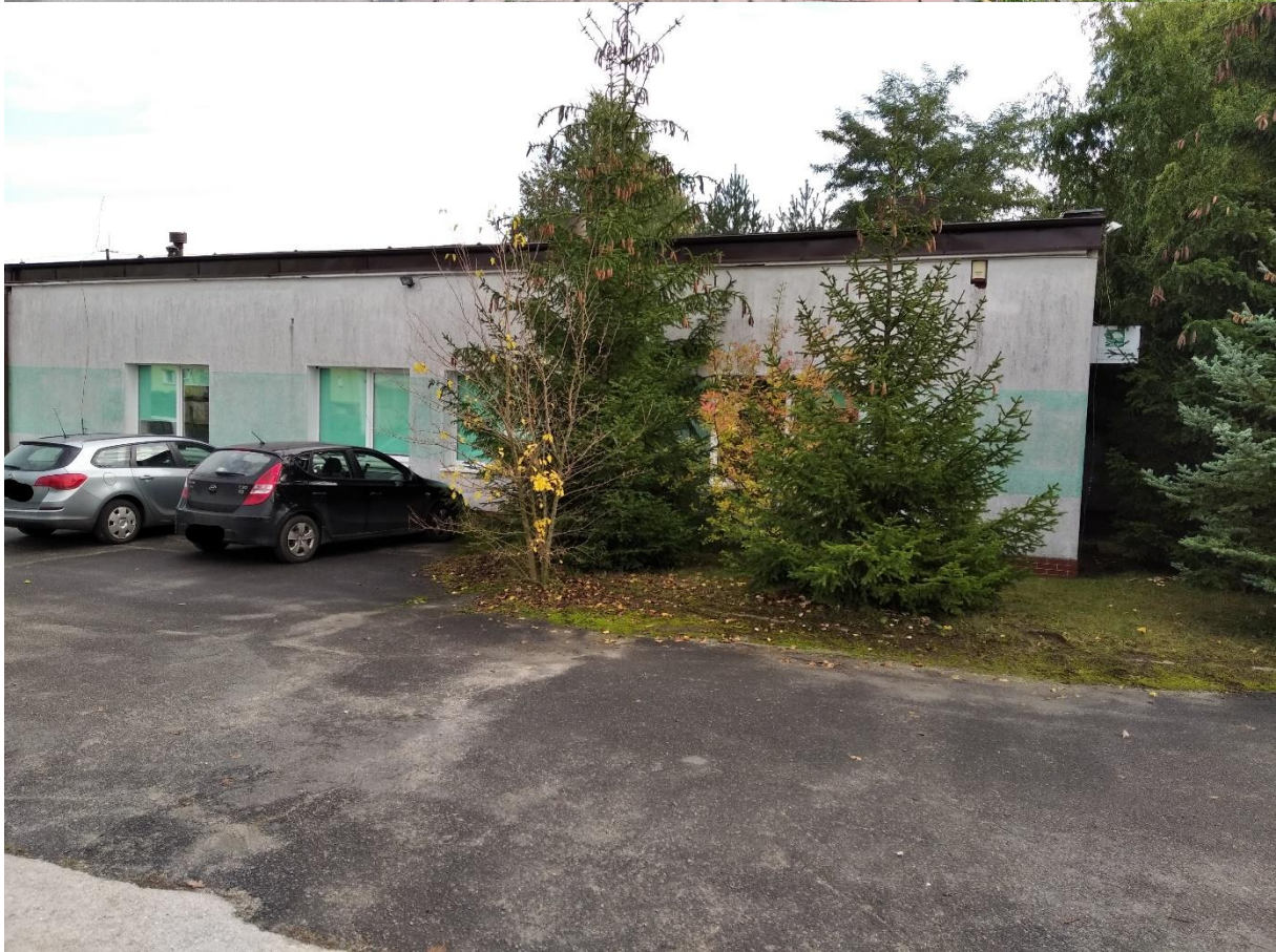
Wejście do budynku jest oddalone od ulicy ok 6 m.
