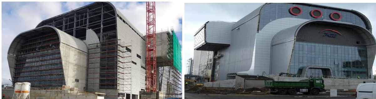
Fot. 20. Instalacja termicznego przetwarzania z odzyskiem energii spółki PGE przy ul. Ciepłowniczej.
