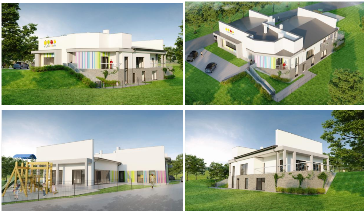
Rys. 13. Niepubliczne przedszkole „Przystań Malucha” w Rzeszowie, ul. Nowe Wzgórze 2.
