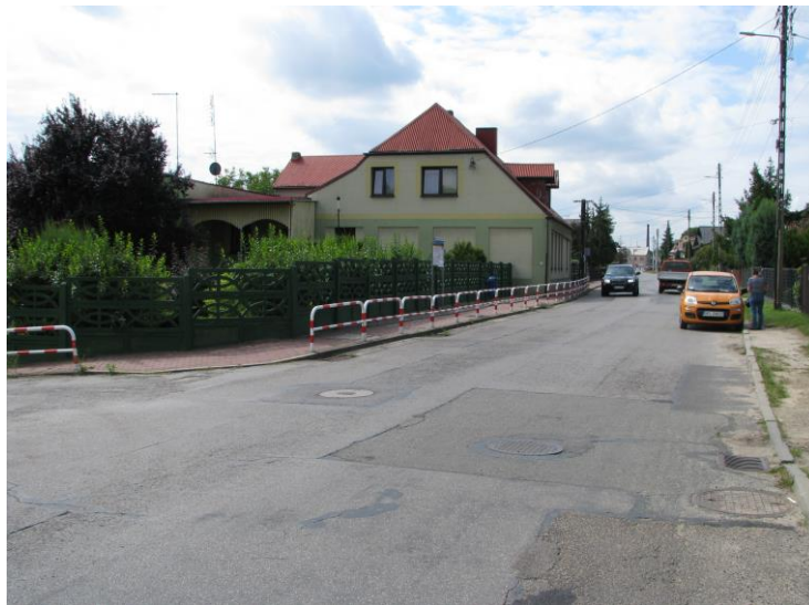
Fot. 15. Kłobuck, RB5. Badany odcinek ul. Elizy Orzeszkowej w kierunku skrzyżowania z ul. Zamkową.
