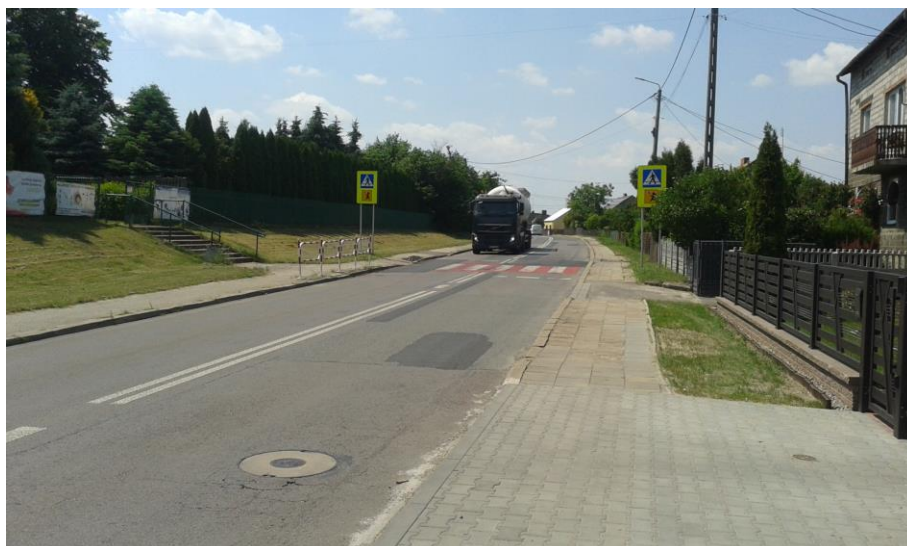
Fot. 6. Łobodno, RB2. Badany odcinek ul. Sienkiewicza w kierunku Kłobucka.
