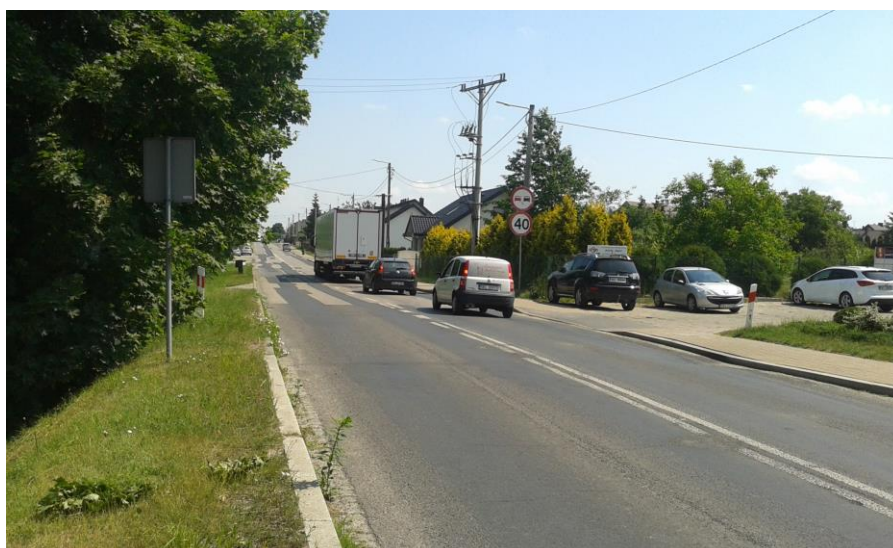
Fot. 3. Kłobuck, RB1. Badany odcinek ul. 11 Listopada w kierunku Łobodna.
