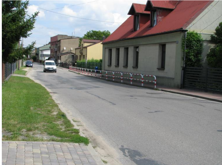
Fot. 14. Kłobuck, RB5. Badany odcinek ul. Elizy Orzeszkowej w kierunku skrzyżowania z ul. Cichą.
