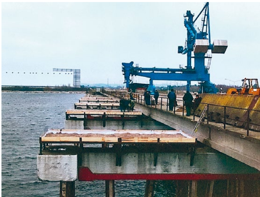
Ryc. 6. Widok na przygotowane platformy (fot. Sz. Bzoma)
