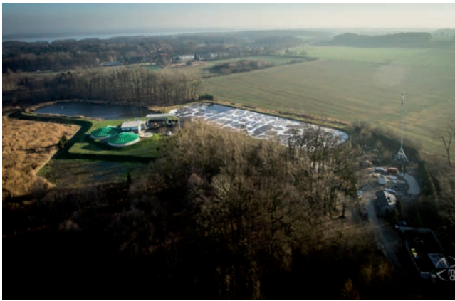
Fot. 15. Widok oczyszczalni w Świerklańcu po modernizacji
