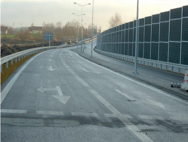
Fot. 1. Budowa północnej obwodnicy miasta Pszczyna
