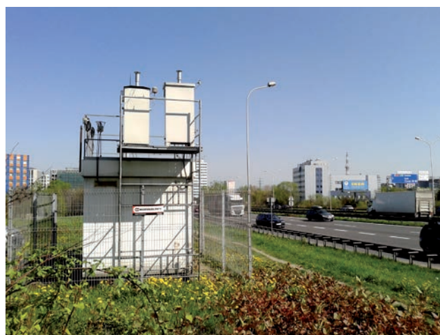
Fot. 4. Automatyczna stacja komunikacyjna Katowice A4
