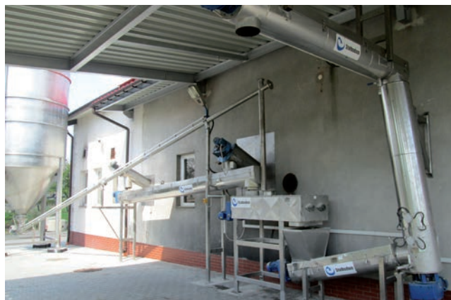
Fot. 12. Układ higienizacji osadu OŚ Foch III w Knurowie
