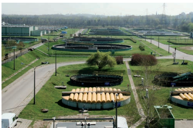
Fot. 7. Oczyszczalnia ścieków Radocha II w Sosnowcu
