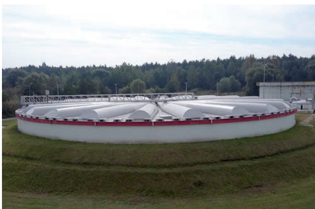
Fot. 9. Oczyszczalnia ścieków Jaworzno Dąb zmodernizowany osadnik wstępny
