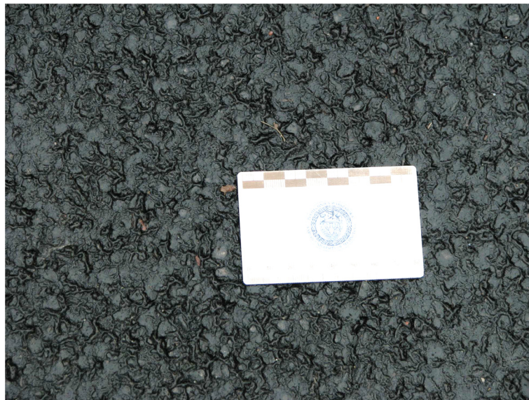
Fot. 2.1. Warstwa z mieszanki BBTM 8A
