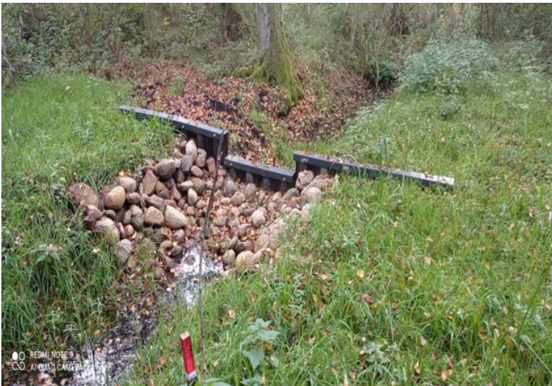
Zdjęcie nr 2. Stały próg z PCV na Torfowisku Grzybowo.
