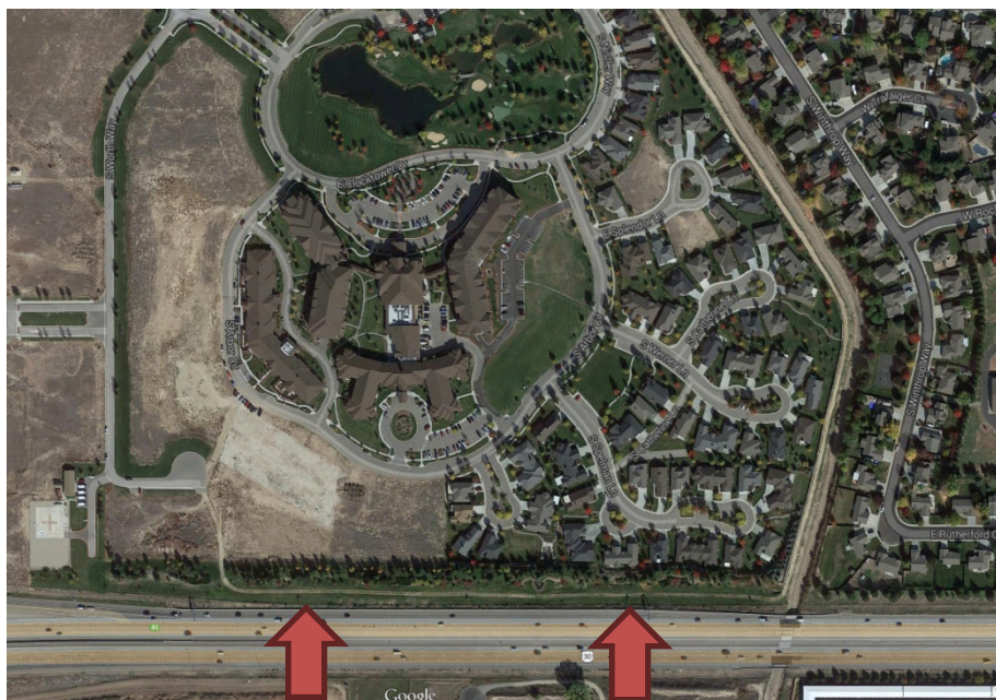
Rys. 7.11. Rzut z góry na osiedle chronione przez wał ziemny – droga stanowa nr 84 Meridian, US [27] (strzałką zaznaczono wał).
