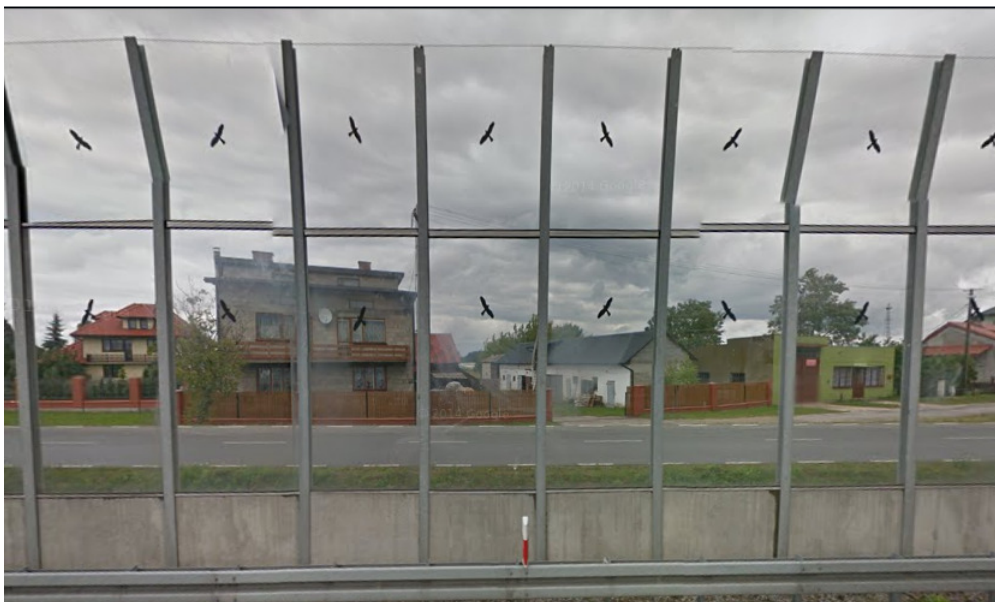
Rys. 7.13. Droga serwisowa wzdłuż ekranów akustycznych i chroniona zabudowa DK7 (Białobrzegi [27])
