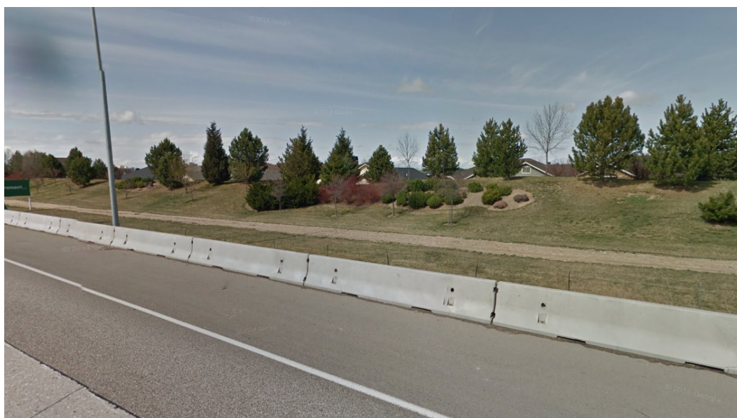
Rys. 7.12. Widok na wał ziemny chroniący osiedle przed hałasem – droga stanowa nr 84 Meridian, USA [27]
