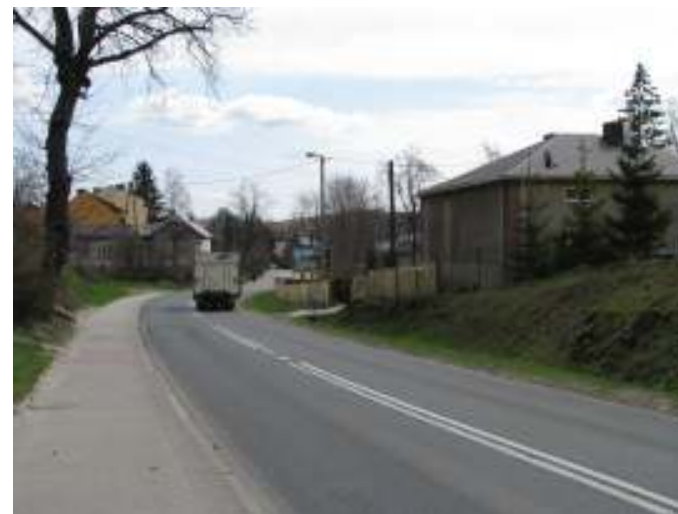
Fot. 6. Pilica, RB2. ul. Zawierciańska (DW 790) w kierunku centrum miasta
