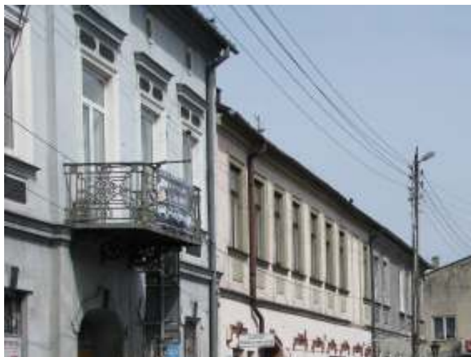
Fot. 1. Pilica, RB1. Lokalizacja punktu pomiarowego przy ul. Krakowskiej (DW 794)
