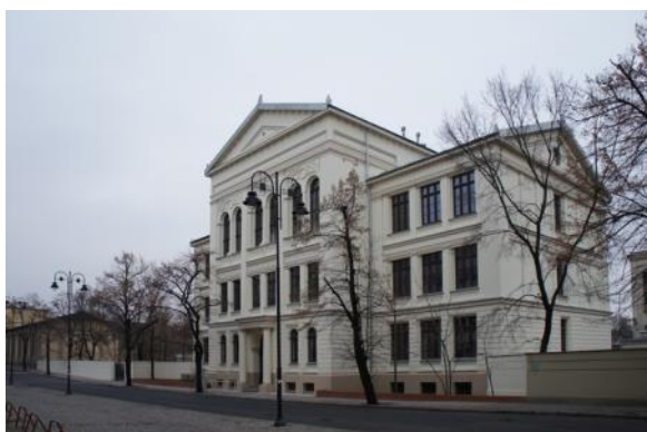
Eklektyczny budynek z 1876r. Zespołu Szkół Plastycznych im. Leona Wyczółkowskiego w Bydgoszczy po remoncie elewacji ze środków MKiDN (2011r)
