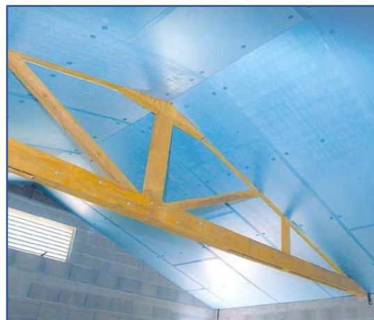
ujynego? fot. 3 RAVATHERM: ocieplenie dachu płytami XPS
