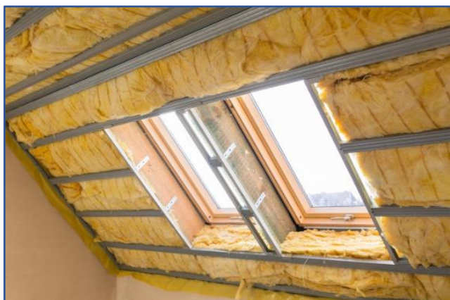
fot. 2 domoweklimaty: dach ocieplany wełną mineralną
