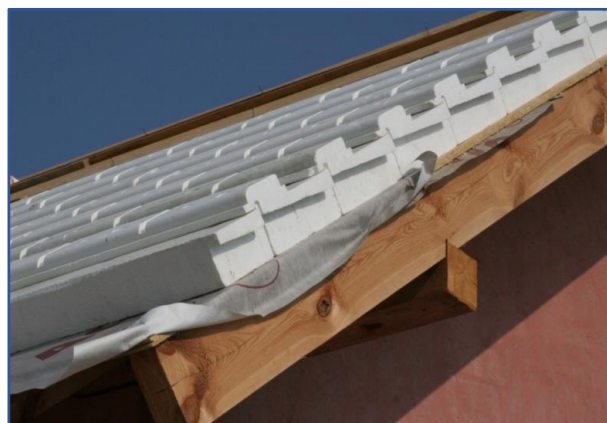
fot. 1 Lipińscy Domy: dach ocieplany styropianem
