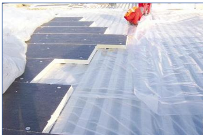
fot. 4 dachy płaskie: dach ocieplany płytami PIR
