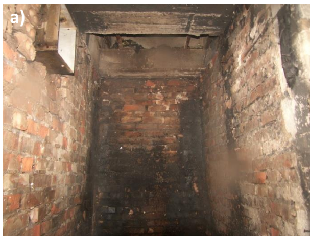
Fot. 57 a-b: Początek szybu wentylacyjnego, przez który gorące gazy pożarowe wędrowały do sali koncertowej. Liczne widoczne nieszczelności były jednocześnie przyczyną pojawienia się zadymienia w różnych miejscach, często odległych od ogniska pożaru.
