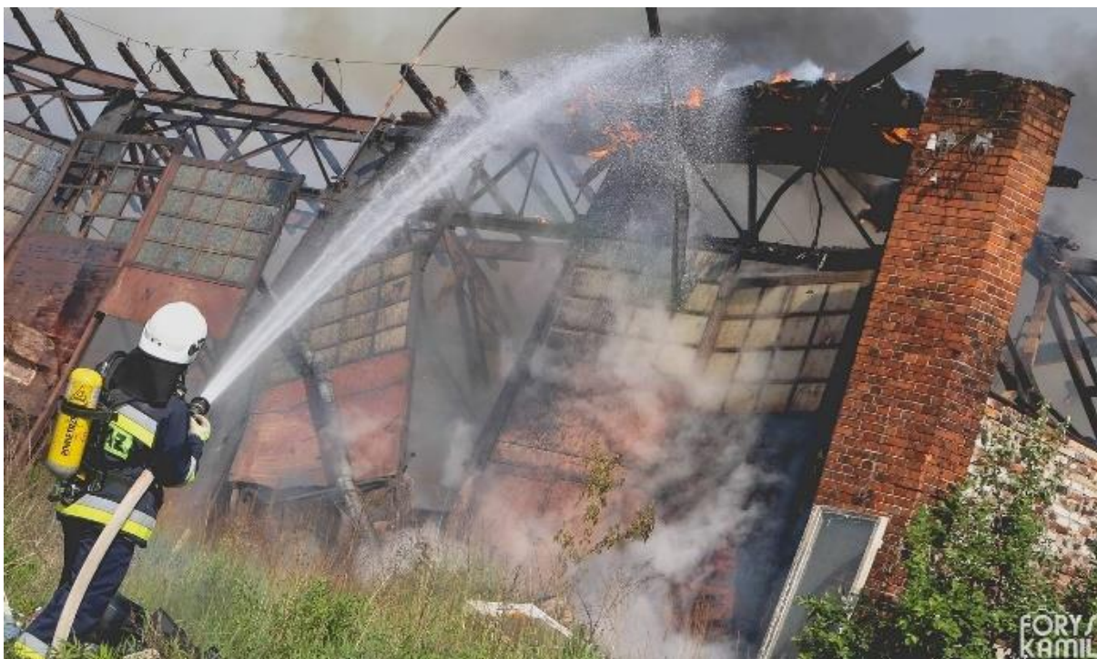
Fot. 153: Pożar w budynku parowozowni. Podczas działań gaśniczych strażacy starali się przebywać poza strefą zawalenia. W niektórych miejscach pochYLENIE ścian budynku w stronę wnętrza pozwoliło na pewne zbliżenie się do budynku. (fot. Kamil Foryś, KamiFoto)
