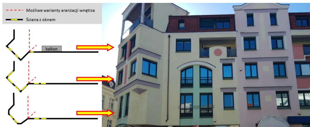
Fot. 115: Widok z zewnątrz pozwala zauważyć, że zależnie od kondygnacji pomieszczenia będą miały nieco inne kształty oraz rozkład okien, które są punktami orientacyjnymi.
