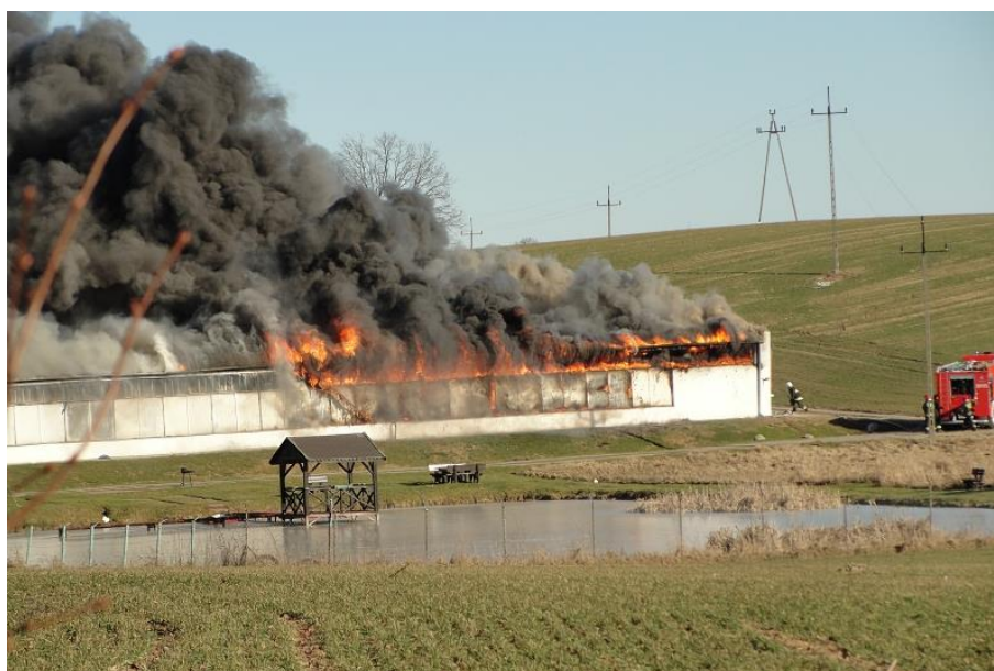
Fot. 17: Pożar kurnika napędzany wiatrem w miejscowości Rejczuchy w dniu 16 lutego 2015 r. Wytworzenie ścieżki przepływu spowodowało bardzo szybki i intensywny rozwój i rozprzestrzenienie pożaru. Analizując kierunek wędrówki dymu można stwierdzić obecność silnego wiatru oraz jego wpływ na dynamikę zdarzenia. W tym momencie, w obiekcie przebywa 3 strażaków a kolejnych dwóch znajduje się po drugiej stronie obiektu, w pobliżu wejścia w połowie obiektu, które stało się wylotem dla dużych ilości dymu. (fot. Grzegorz Szewczyk)
