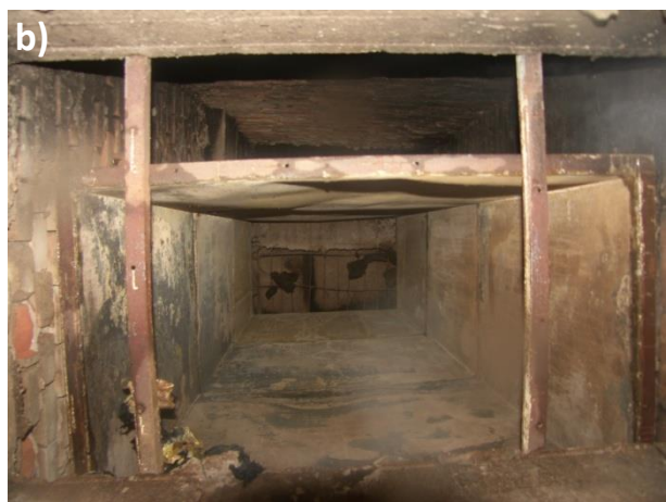
Fot. 57 a-b: Początek szybu wentylacyjnego, przez który gorące gazy pożarowe wędrowały do sali koncertowej. Liczne widoczne nieszczelności były jednocześnie przyczyną pojawienia się zadymienia w różnych miejscach, często odległych od ogniska pożaru.
