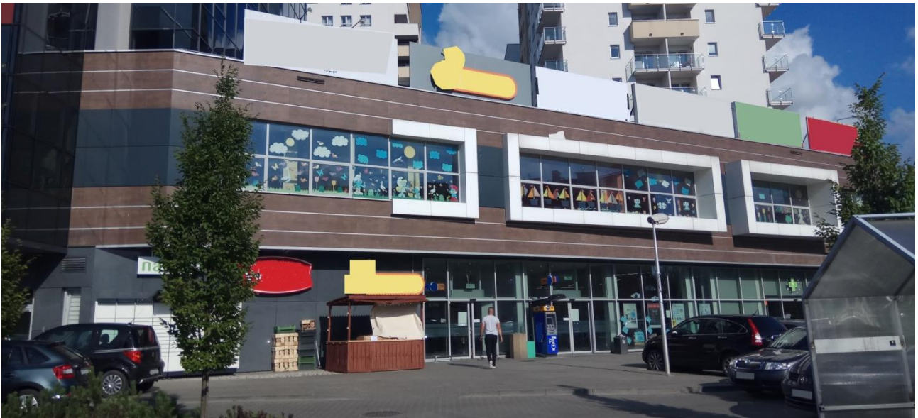
Fot. 28: Rozpoznanie pod kątem możliwego scenariusza rozwoju pożaru: lokal na piętrze – przedszkole. W określonych dniach i godzinach spodziewana obecność dzieci (utrudniona ewakuacja, konieczność bardzo dokładnego przeszukania). Duże otwarte przestrzenie, wysokie sufity – ułatwiające rozwój i rozprzestrzenianie pożaru. Bardzo duża powierzchnia okien pozwalająca na dynamiczny rozwój pożaru. Niewykluczona ewakuacja za pomocą sprzętu z wysokości!
