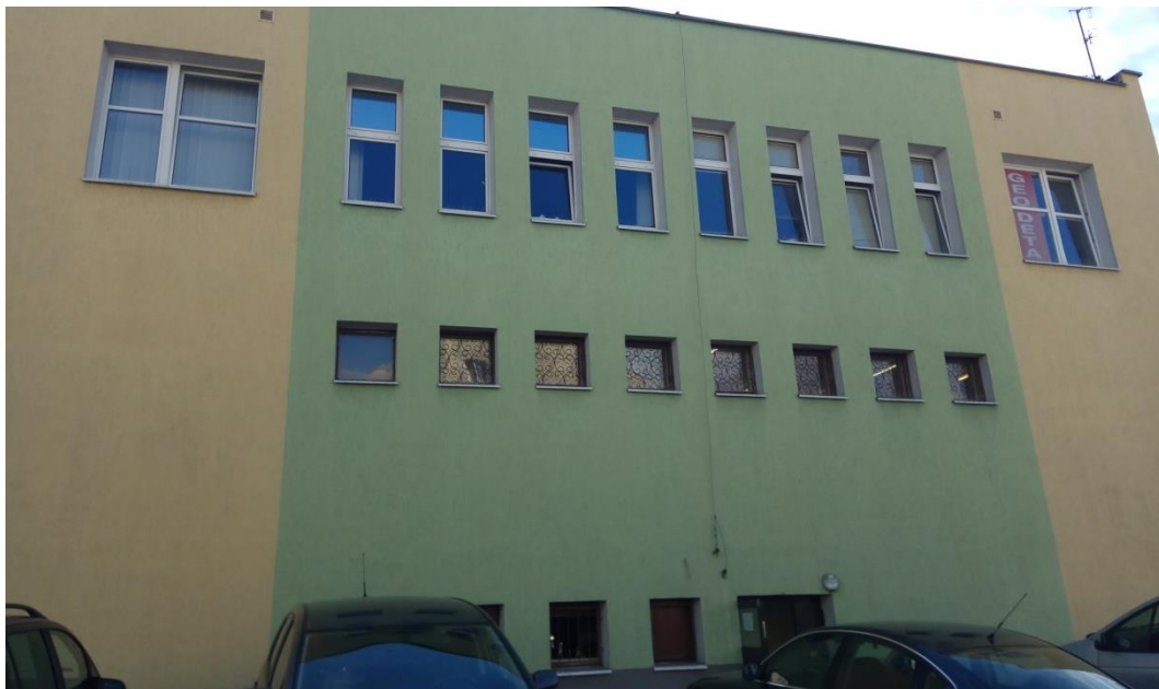
Fot. 31: Rozpoznanie otworów okiennych. Okna na ostatniej kondygnacji należą do kilku pomieszczeń. Pierwsze okno z lewej (żółta powierzchnia) należy do oddzielnego pomieszczenia. Jedno skrzydło jest uchylone. Kolejne cztery okna (na zielonej powierzchni) należą do tego samego pomieszczenia (brak widocznych ścian). Jedno okno uchylone. W kolejnych czterech oknach – trzy są uchylone. Ostatnie okno jest uchylone i należy prawdopodobnie do oddzielnego pomieszczenia. W rzędzie poniżej niemal wszystkie okna posiadają kraty (ewakuacja, w tym strażaków – niemożliwa). Na poziomie gruntu kolejne okna z kratami.
