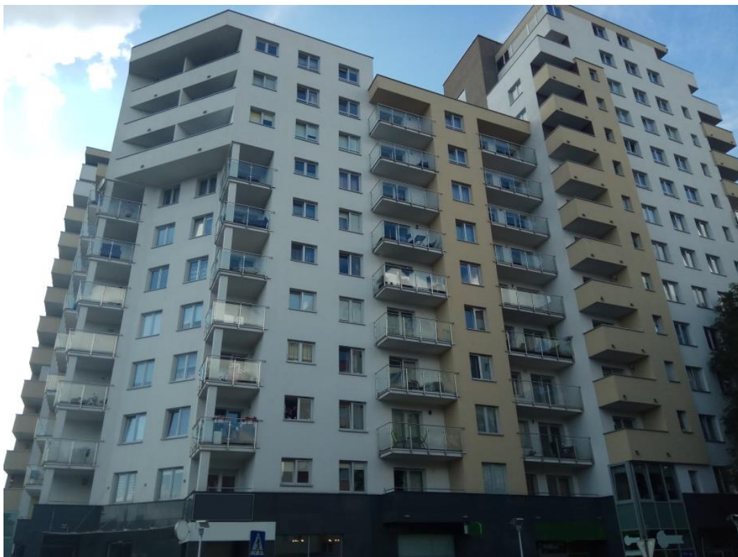
Fot. 44: Współczesne budownictwo mieszkalne sprzyja występowaniu nieregularności w powierzchniach czy kształtach pomieszczeń. Często jest występowanie lokali użytkowych na poziomie gruntu. Ich wyposażenie oraz konfiguracja będą powodować, że pożar będzie przebiegał inaczej, aniżeli w mieszkaniu.
