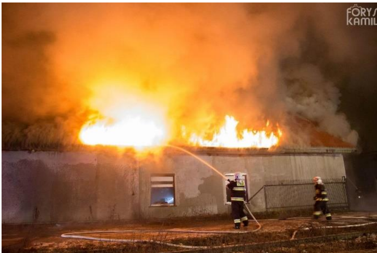
Fot. 151: Rozprzestrzeniający się pożar budynku magazynowego objął konstrukcję dachu, powodując konieczność przeprowadzania natarcia bezpośredniego na jego poszycie. (fot. Kamil Forys, KamiFoto)
