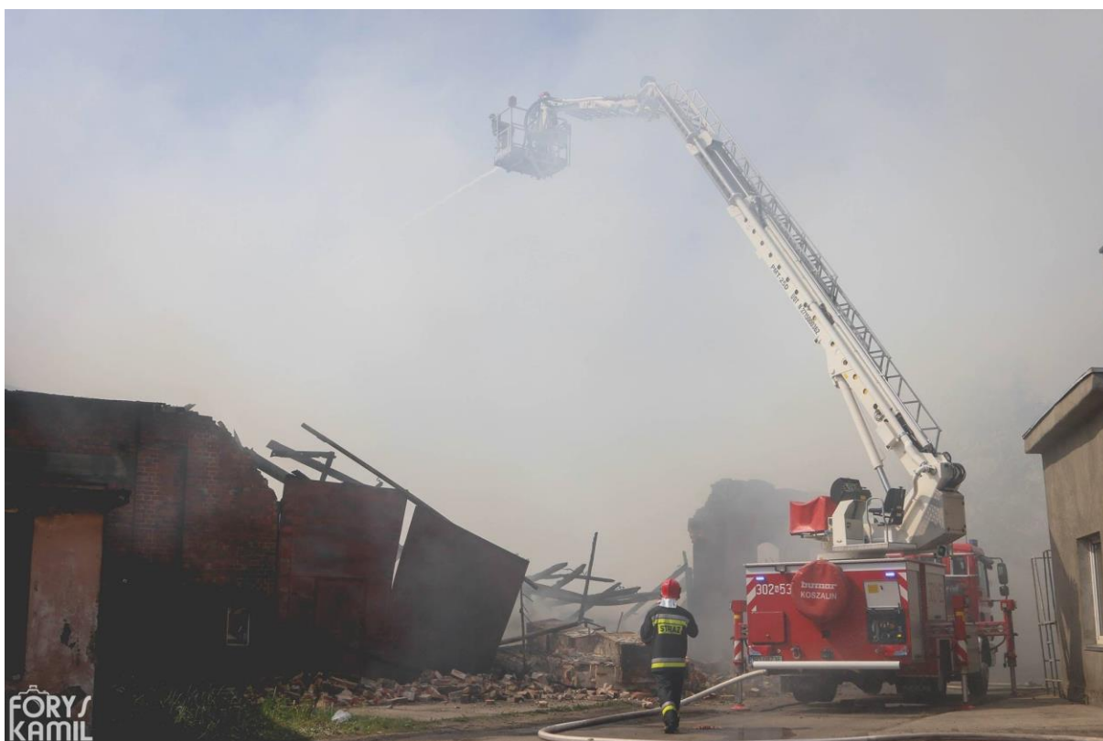
Fot. 152: Pożar w budynku parowozowni w dniu 29.05.2016 r. w Olsztynie. W tym nieużywanym budynku zgromadzono dużą ilość różnego rodzaju odpadów. Fatalny stan techniczny oraz intensywny rozwój pożaru doprowadziły do zawalenia się części dachu i konstrukcji w trakcie działań. Strażacy prowadzili natarcie zewnętrzne m.in. z kosza podnośnika. (fot. Kamil Forys, KamiFoto)
