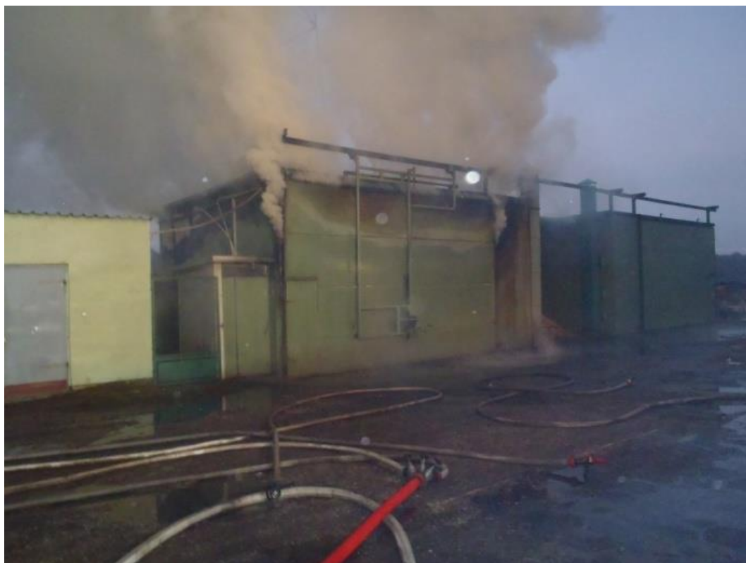
Fot. 60: Odbarwienia farby na ścianie wyraźnie wskazują na obecność znacznych ilości ciepła w budynku. (fot. KP PSP w Gnieźnie)
