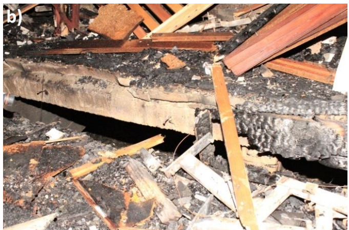
Fot. 58 a-b: Ujście gazów pożarowych pod konstrukcją podłogi widowni w sali koncertowej. Widoczne po prawej stronie przerwy posłużyły za ujście gazów pożarowych i ostateczne podpalenie krzeseł. Prawdopodobnie widoczne na zdjęciach rozwiązania konstrukcyjne służyć miały istnieniu naturalnej wentylacji obiekcie, w którym przewidywano obecność znacznej liczby osób.
