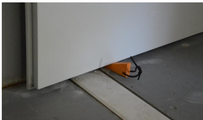
Fot. 121: Drzwi sprawdzone i zabezpieczone a jednocześnie oznakowane za pomocą klina (klin drewniany z pętlą własnej produkcji wykonany przez strażaków z JRG Łobez, woj. Zachodniopomorskie oraz Ośrodka Szkolenia KW PSP w Szczecinie z siedzibą w Bornem Sulinowie).
