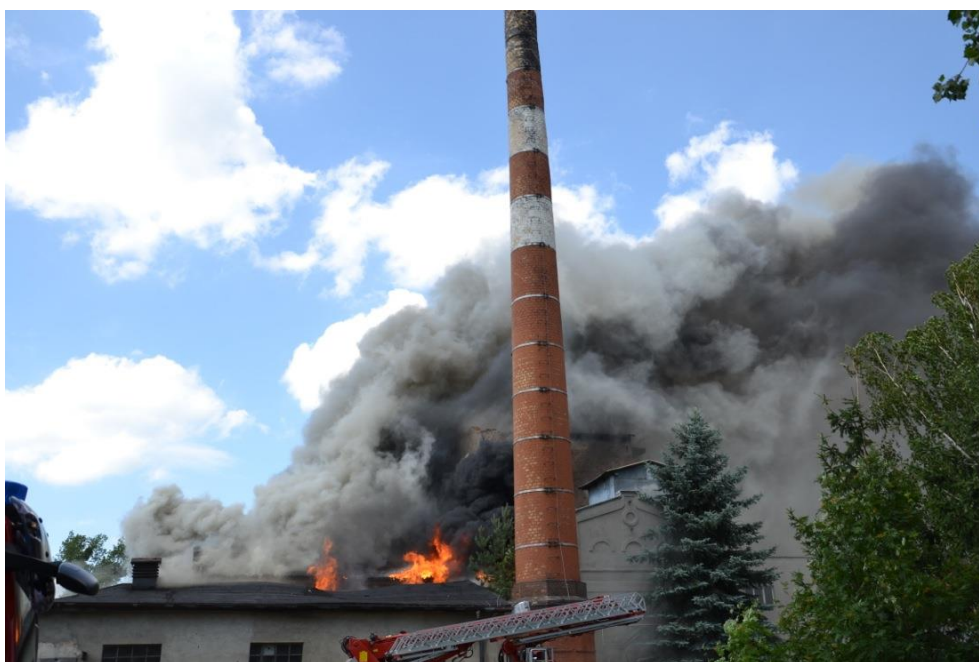
Fot. 47: Pożar w obiekcie przemysłowym. Ognisko pożaru znajduje się tam, gdzie dym wydobywa się najszybciej i unosi najbardziej dynamicznie do góry. W obserwowanym przypadku stwierdzenie tego jest utrudnione z uwagi na wiatr. Kolejnym elementem jest kolor dymu – ciemniejszy dym wskazuje ognisko pożaru. Ma dużą gęstość a o ciśnieniu i temperaturze świadczy kłębiecie się (turbulencja). Dodatkowo,
