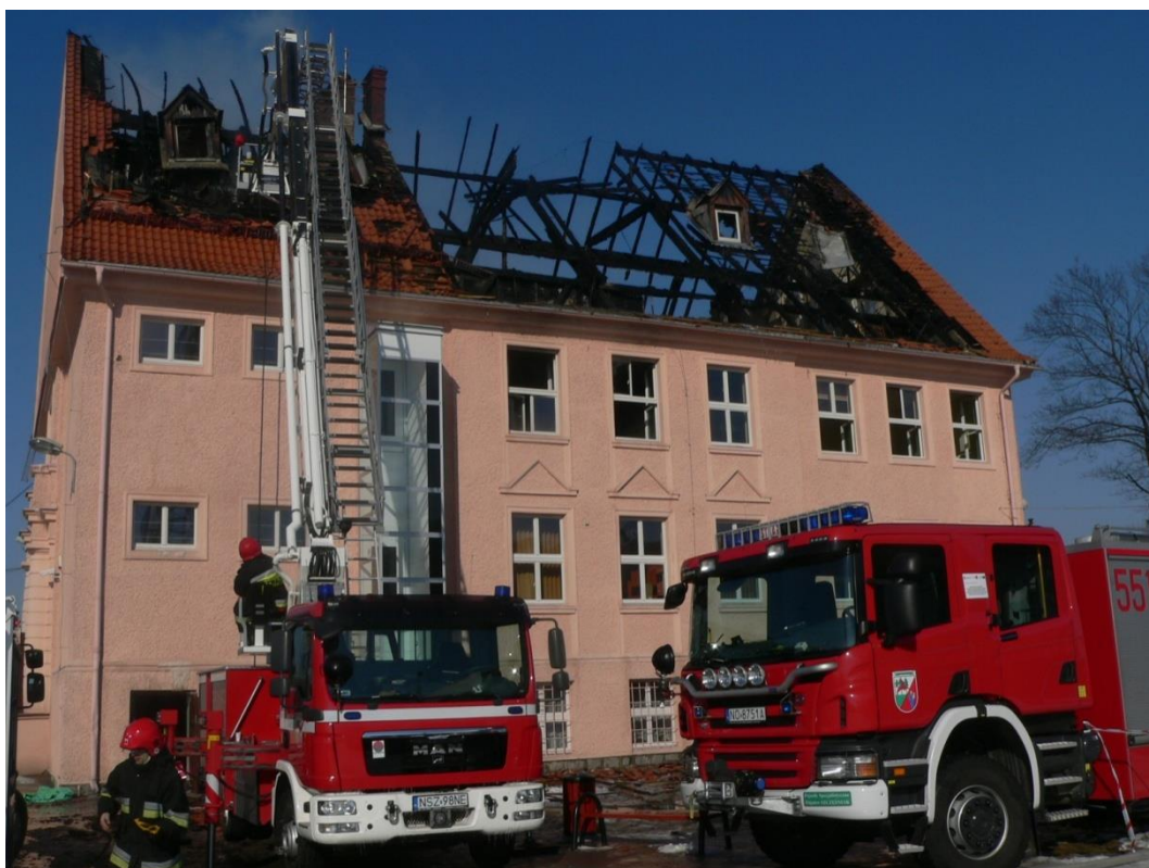
Fot. 24: Skutki pożaru palnej konstrukcji dachu na budynku gimnazjum w Wielbarku (powiat szczycieński) w dniach 02-03 marca 2011 roku. (fot. KP PSP w Szczytnie)
