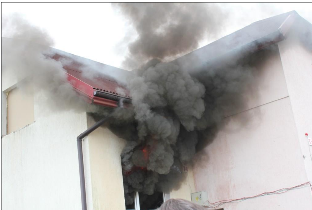
Fot. 144: Pali się pomieszczenie na 1. piętrze, a pożar spowodował wypadnięcie szyby. Gęsty czarny dym wydobywa się z okna bardzo intensywnie a ponadto zaczyna pojawiać się płomień. Zastosowanie natarcia z zewnątrz przez okno poprzez rozbicie prądu zwartego o sufit płonącego pomieszczenia przyniesie znaczne korzyści taktyczne: schłodzenie gazów i zwilżenie płonących paliw, zmniejszenie dynamiki rozwoju pożaru, zubożenie gazów pożarowych mgłą wodną. Należy również zwrócić uwagę na ryzyko rozprzestrzenienia pożaru na konstrukcję dachową od spodu. (fot. KW PSP w Olsztynie)
