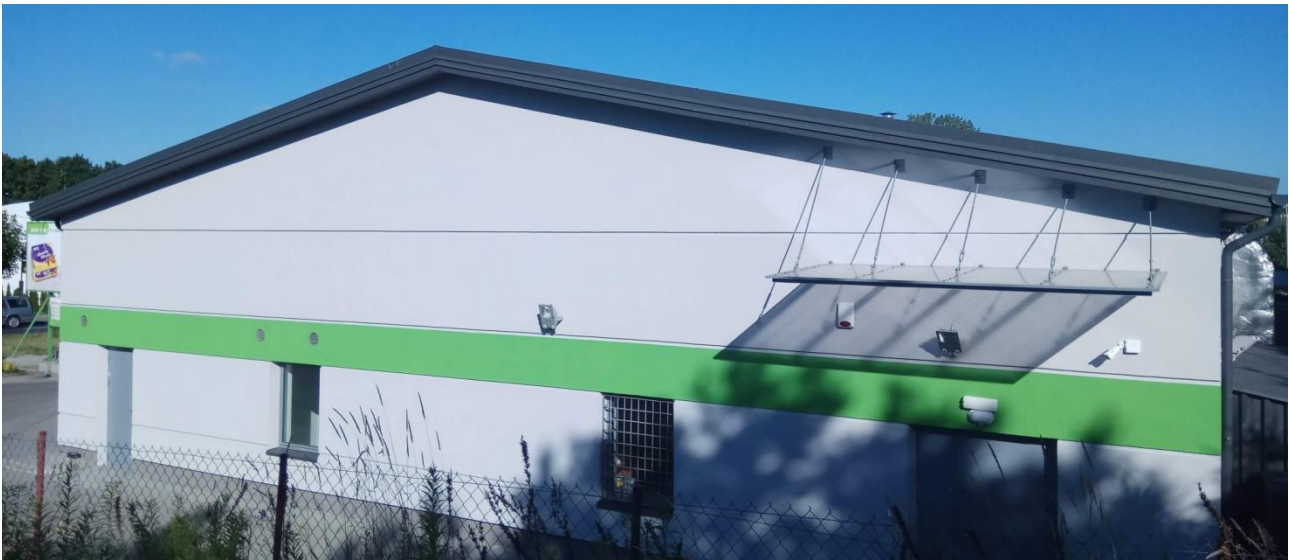
Fot. 21: Zdjęcie fasady budynku dyskontu spożywczego widocznego na fot. 20 oraz fot. 14 , wykonane po zakończeniu remontu wynikającego z pożaru konstrukcji dachowej. Strażacy muszą być świadomi rodzaju konstrukcji oraz wynikających z tego faktu zagrożeń.
