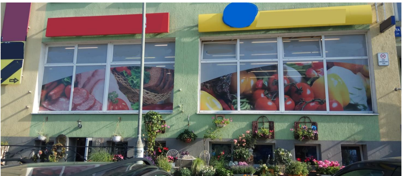
Fot. 29: Rozpoznanie pod kątem możliwego scenariusza rozwoju pożaru: lokal sklepu spożywczego. Połączona kubatura pomimo podzielonych okien. Duże otwarte przestrzenie, wysokie sufity – ułatwiające rozwój i rozprzestrzenianie pożaru. Bardzo duża powierzchnia okien pozwalająca na rozwój pożaru. Dwa okna są uchylone. Prawdopodobnie możliwa ewakuacja oraz działania od drugiej strony w punkcie przyjęcia towaru, który występuje niemal zawsze w tego typu obiektach
