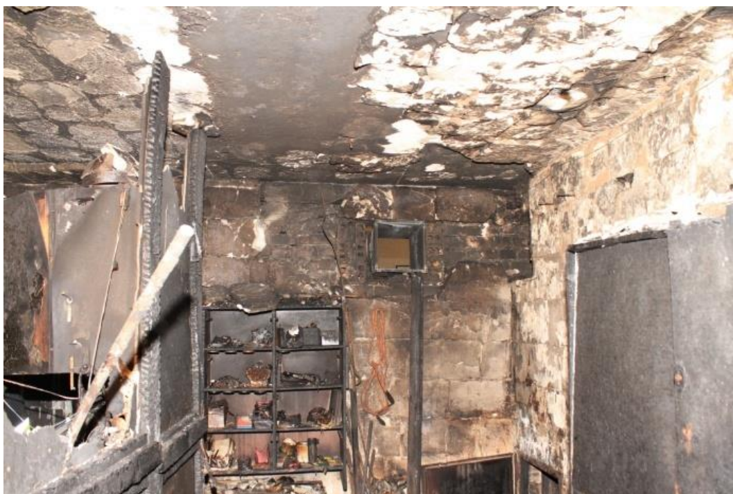
Fot. 53: Pomieszczenie, w którym powstał pożar. W ścianie naprzeciw widać otwór wentylacyjny prowadzący do sali gimnastycznej. Po prawej na dole i na górze widać otwory pozwalające na wędrowkę dymu do zamurowanej przestrzeni, w której również składowano różnorodne materiały palne. W pomieszczeniu za ścianą po prawej stronie znajdował się początek szybu wentylacyjnego, którego ujście usytuowane było pod widownią w sali koncertowej dwie kondygnacje powyżej.
