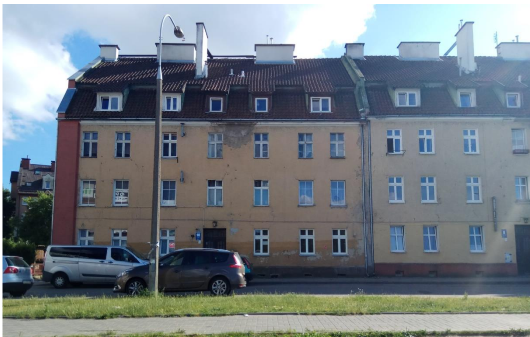
Fot. 40: Zabudowa szeregowa wiąże się z ryzykiem rozwoju pożaru pomiędzy połączonymi obiektami. Budynki wielorodzinne posiadają oddzielne klatki schodowe a dodatkowo każde z mieszkań posiada osobne wejście. Podobnie jak przy budynkach jednorodzinnych utrudnione jest obejście obiektu i obejrzenie jego drugiej strony, gdzie można pozyskać dodatkowe, istotne informacje.
