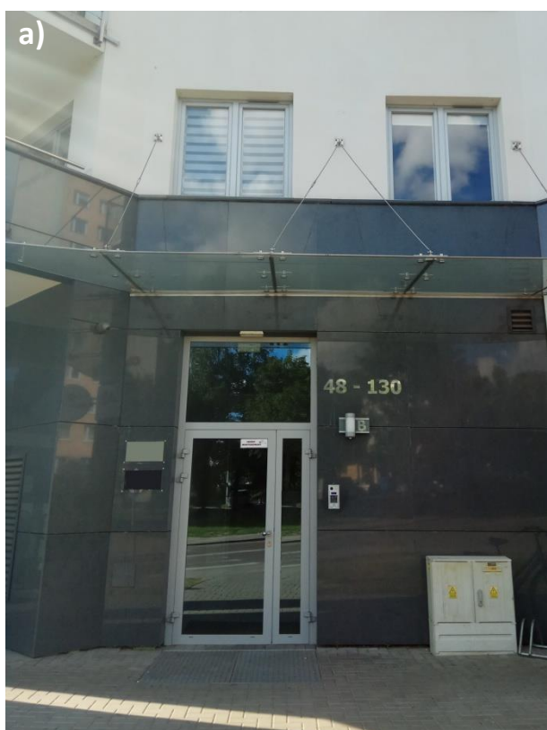
Fot. 41 a-b: Utrudnienia w korzystaniu z drabin. Po lewej : daszek zabezpieczający przed spadaniem przedmiotów na osoby stojące przy obiekcie uniemożliwi rozstawienie drabiny przystawnej i uzyskanie dostępu do pierwszych kondygnacji nad wejściem. Po prawej : bezpośrednie otoczenie budynku (plot, inny budynek, śmietniki, przyczepka) oraz rodzaj podłoża (miękki grunt) uniemożliwią sprawienie drabiny mechanicznej.
