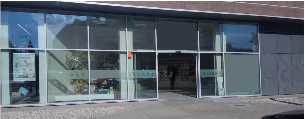
Fot. 26: Rozpoznanie pod kątem możliwego scenariusza rozwoju pożaru: lokal apteki (substancje palne, plastiki, wysoka toksyczność dymu), duża przeszklona powierzchnia (około 40 m 2 )! Rozwój pożaru zależny będzie od materiałów palnych i będzie różnił się od pożaru w mieszkaniu, gdzie gęstość obciążenia ogniowego będzie większa 25 . Stosunkowo łatwe rozpoznanie wewnątrz zanim płaszczyzna neutralna sięgnie do ziemi. Uwaga na pękające okna – lawinowy skok mocy pożaru. Podejrzenie migracji dymu (i pożaru) do lokalu po lewej stronie pomiędzy szybą a ścianką działową. Uwaga na podwieszane sufity! Ewakuacja na poziom gruntu.
