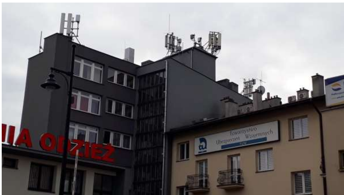
Fot. 1: Widoki anten stacji bazowych ID: 58345 oraz ID: RZE1003, zlokalizowanych: ul. Mikołaja Kopernika 1, 35-069 Rzeszów
