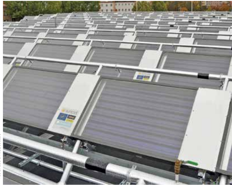
Szwedzki projekt polega na testowaniu kolektorów słonecznych z pompą ciepłą bez użycia energii elektrycznej oraz z akumulatorem pozwalającym na zrównoważone grzanie i chłodzenie
