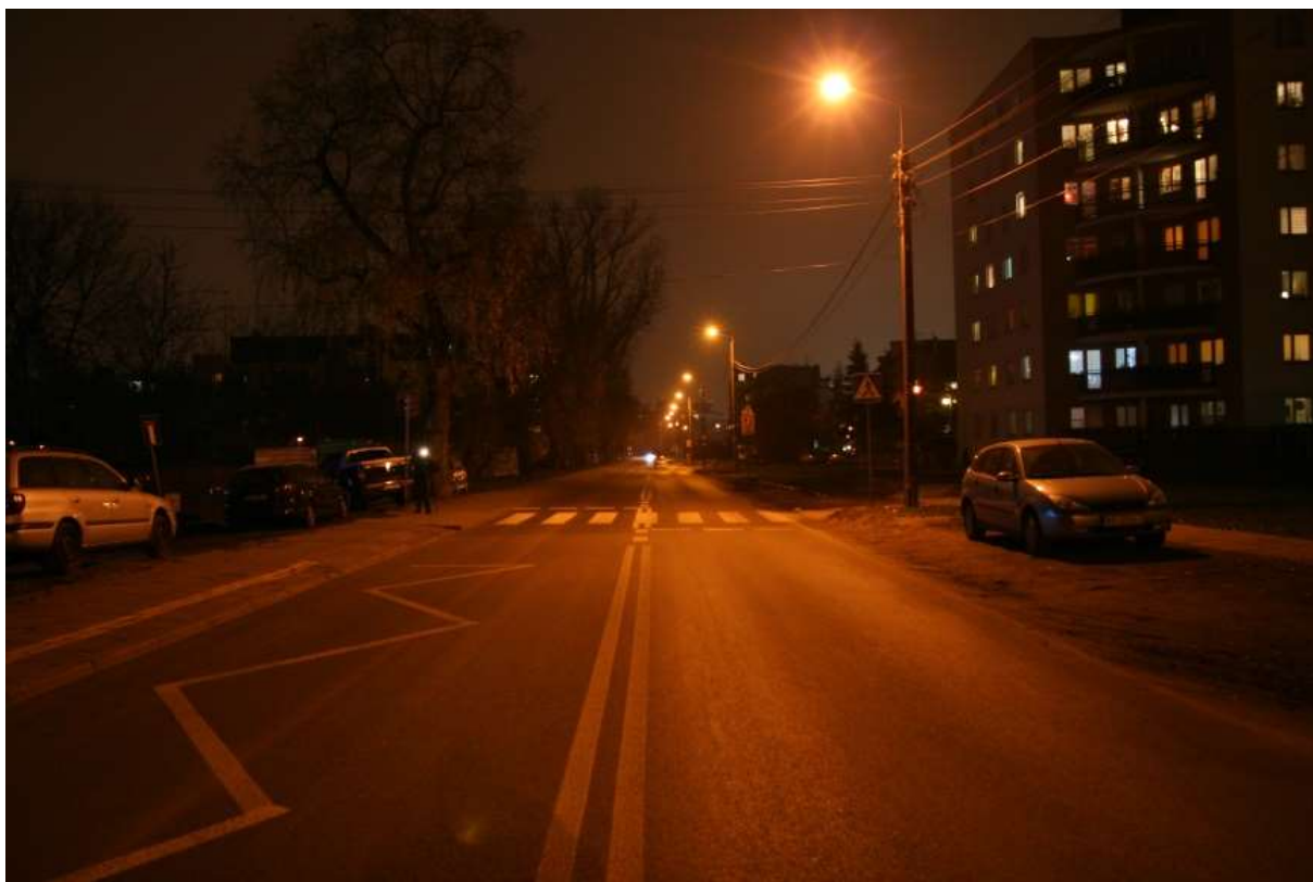
Rys. Z.8.1. Widok instalacji oświetleniowej – przykład 1
