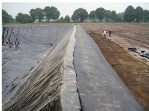
Fot. 6.6. Odkryta laguna przy biogazowni [archiwum ITP-PIB]
