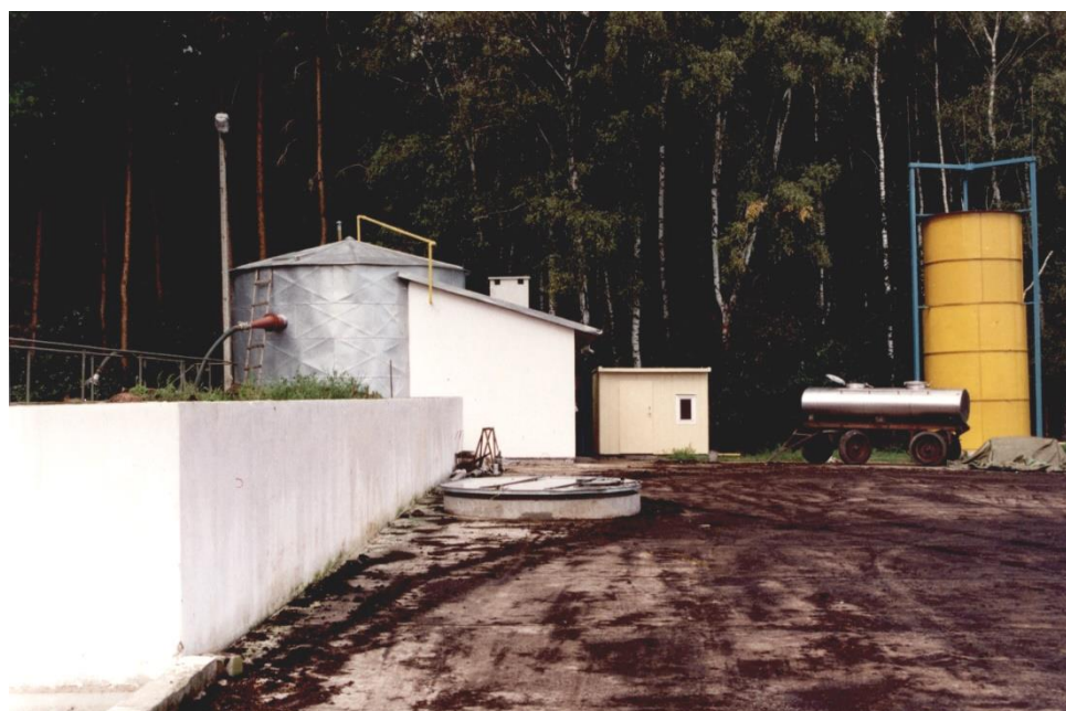
Fot. 6.5. Gotowe obiekty biogazowni i kompostowni w Duchnowie [materiały własne]
