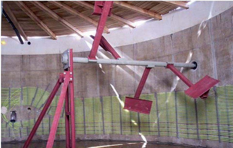
Fot. 2.1. Widok usytuowania mieszadła poziomego (łopatkowego) w komorze fermentacyjnej z instalacją grzewczą [katalog firmy AgriKomp France 2011]
