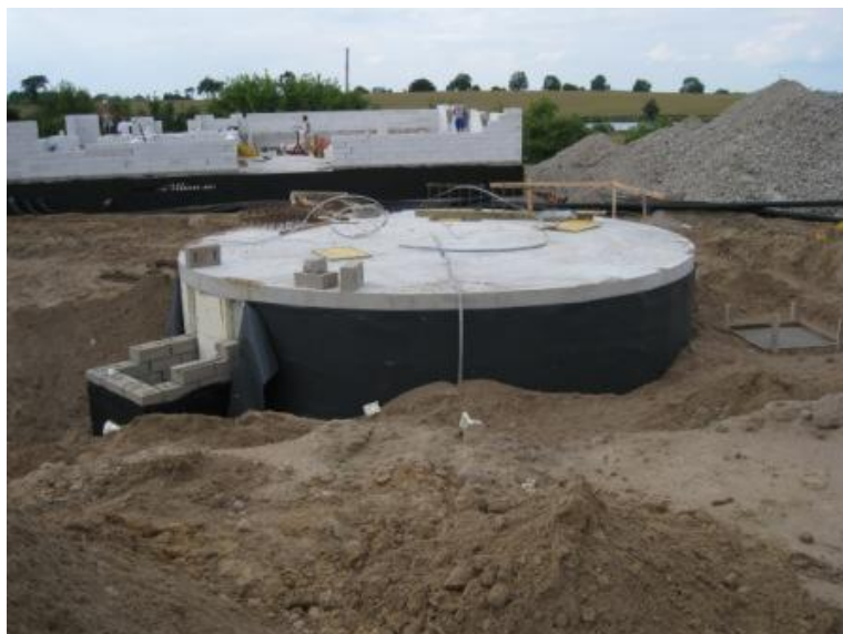
Fot. 6.7. Zbiornik żelbetonowy na poferment [www.inzynierbudownictwa.pl, 2022]
