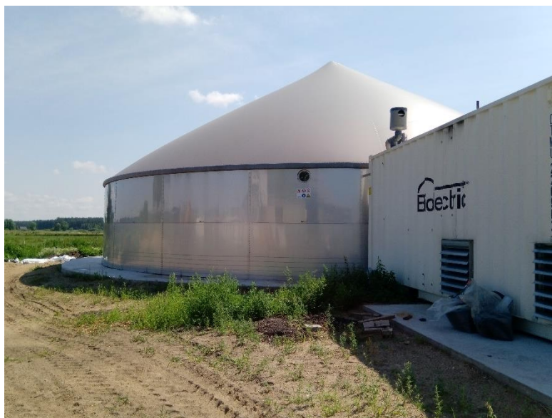
Fot. 7.1. Widok mikrobiogazowni w Ciemnoszyjach z komorą fermentacyjną z biogazem [materiały własne]
