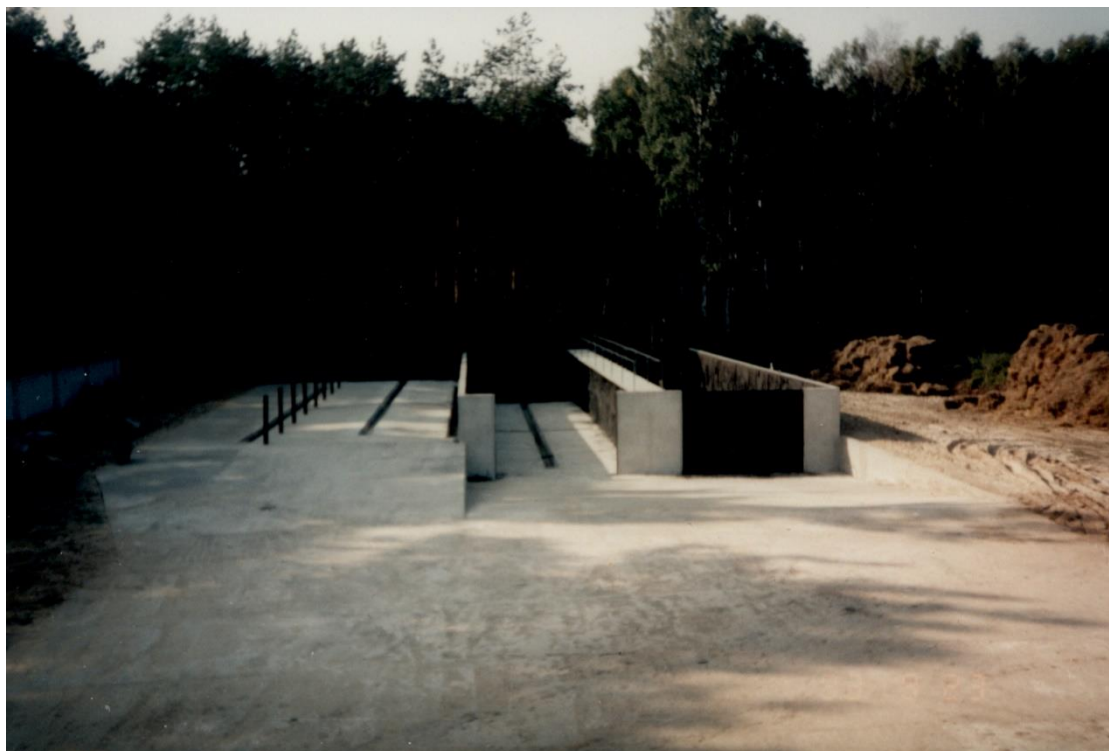
Fot. 6.4. Gotowy obiekt kompostowni w Duchnowie [materiały własne]
