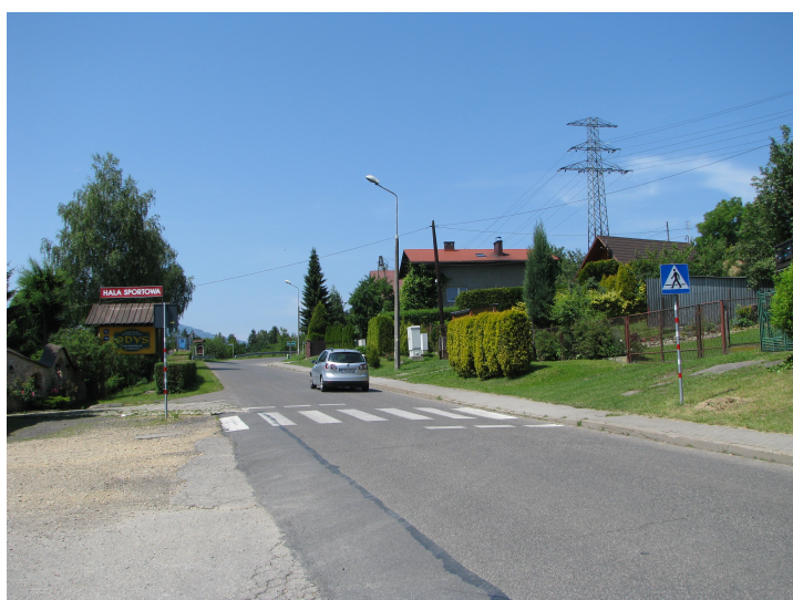
Fot. 6. Tresna, RB2. Badany odcinek ul. Piłkiewicz w kierunku Żywca
