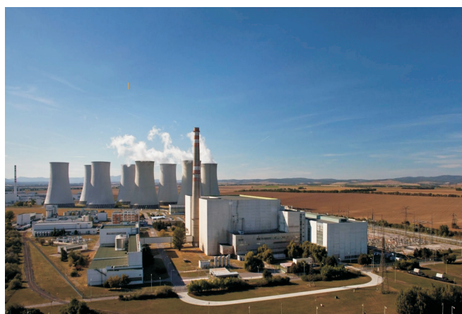
Fot. 2. Elektrownia jądrowa w Bohunicach (źródło: [6]).
