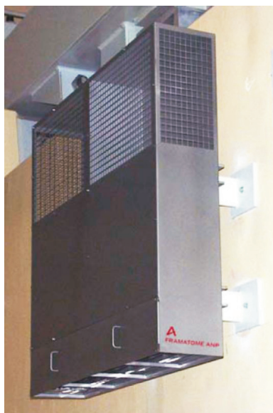
Rys. 6. Pasywny autokatalityczny rekombinator wodoru (źródło: [3]). Fig. 6. Passive autocatalytic recombiner of hydrogen (source: [3]).
