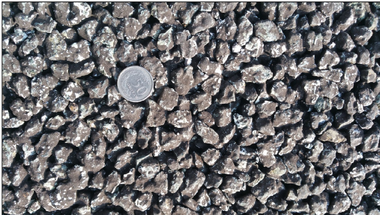
Fot. 3.4. Widok badanej nawierzchni drogowej wykonanej z asfaltu porowatego PA 11
