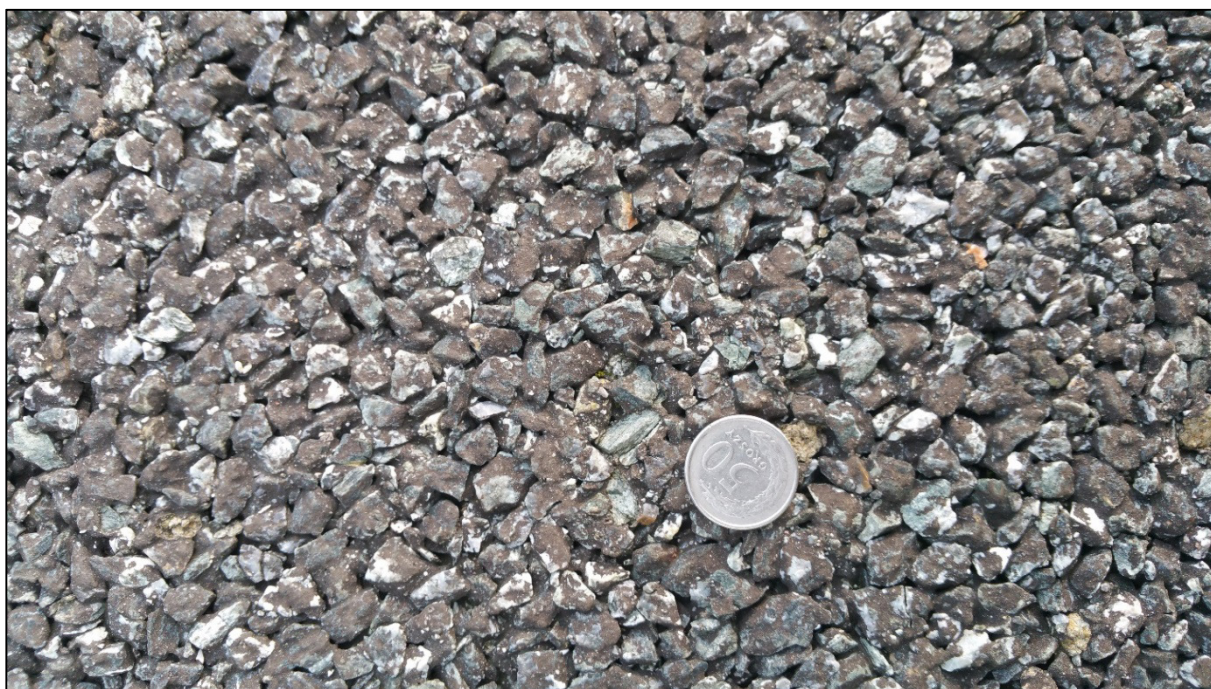
Fot. 3.7. Widok badanej nawierzchni drogowej wykonanej z asfaltu porowatego PA 8
