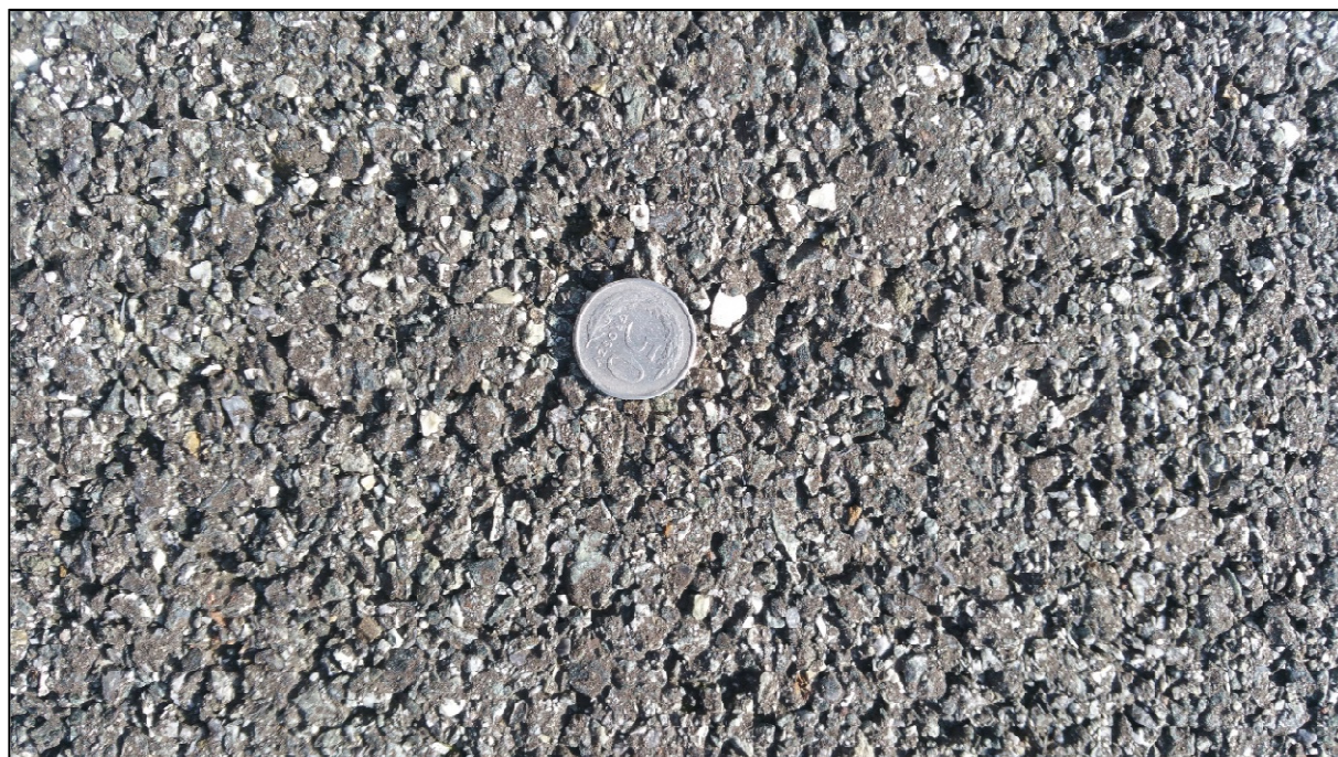
Fot. 3.2. Widok badanej nawierzchni drogowej wykonanej z mieszanki mineralno -asfaltowej typu AC 11
