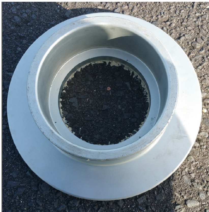
Fot. 2.13. Widok łącznika „in situ” szczelnie zamontowanego na badanej nawierzchni drogowej za pomocą kitu sanitarnego
