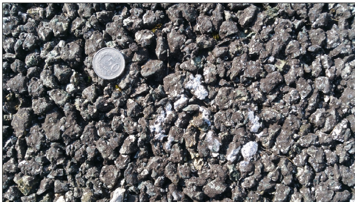
Fot. 3.3. Widok badanej nawierzchni drogowej wykonanej z mieszanki o otwartej strukturze OGFC 11
