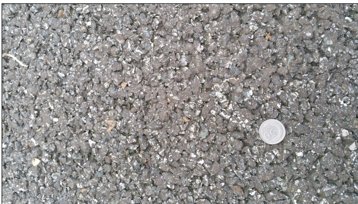
Fot. 3.5. Widok badanej nawierzchni drogowej wykonanej z mieszanki o otwartej strukturze OGFC 8
