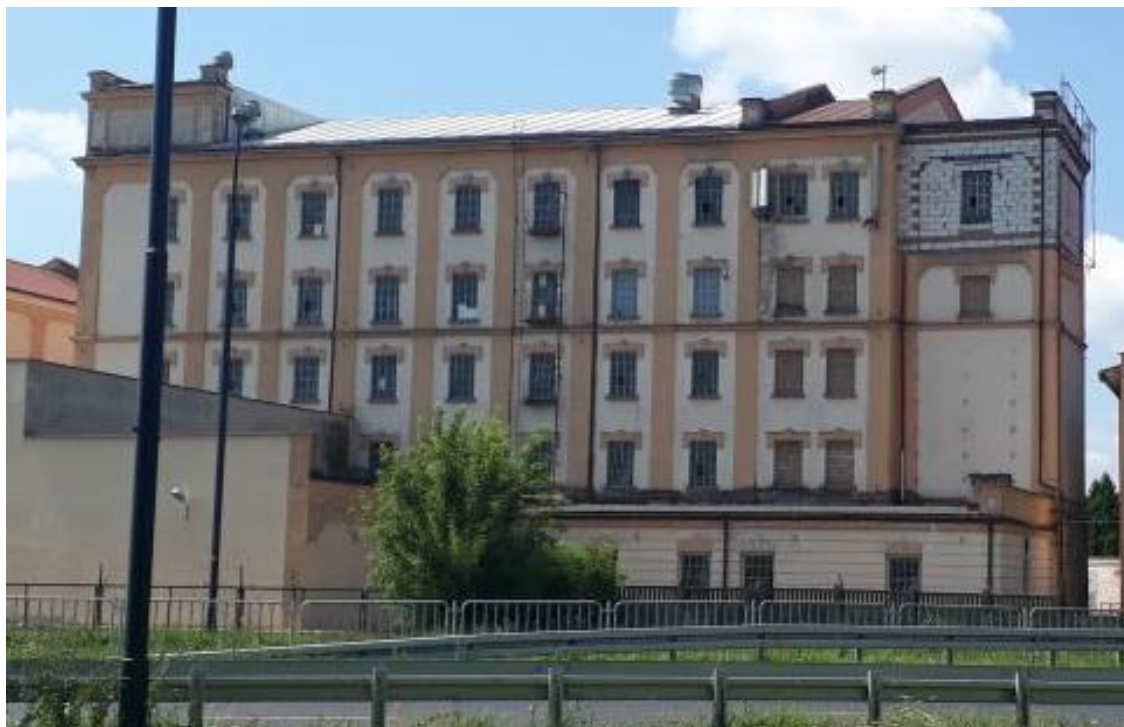
Fot. 1: Widok anten stacji bazowych: ID: ID: BT12754, ID: LUB1050A, zlokalizowanych: ul. Działkowa 45, 20-121 Lublin
