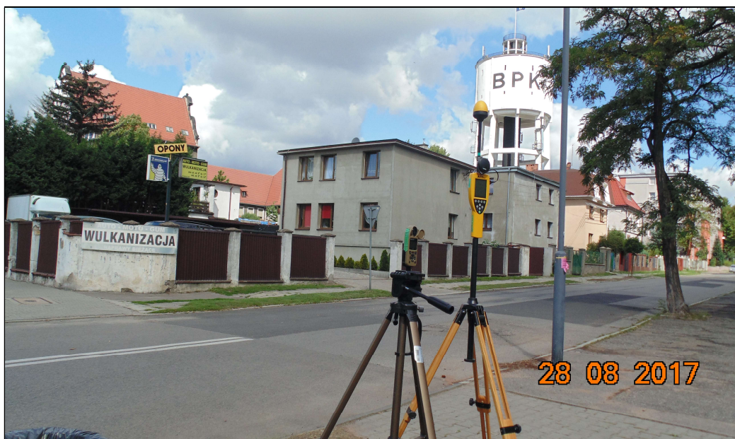
Fot. 3. Fragment instalacji radiokomunikacyjnej zlokalizowanej na konstrukcji obiektu wieży ciśnień
