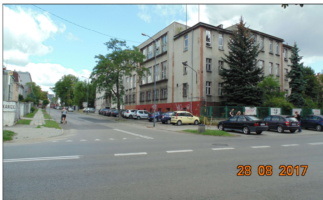
Fot. 2. Rejon badań, widok w kierunku północno – wschodnim
