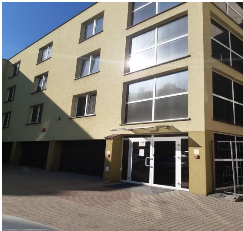
Rys. Nr 2 Wejście główne do Archiwum zakładowego KOWR OT OPOLE od strony bramy wjazdowej na ul. 1 Maja
