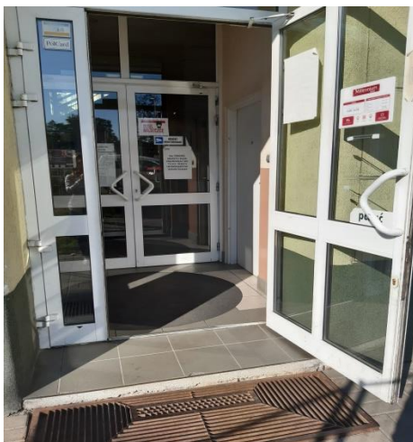
Rys. Nr 5 Wejście główne do siedziby KOWR OT OPOLE od ul. Reymonta z progiem oraz drzwi podwójne.
