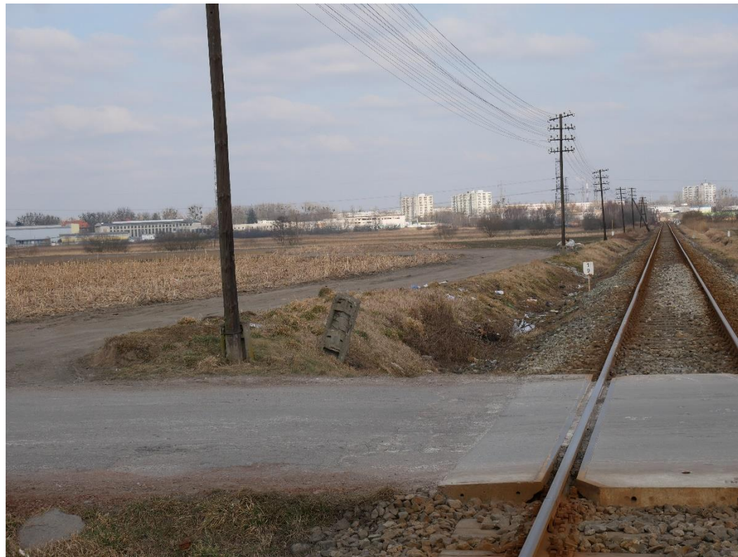
Fot. 10. Widok na drogę gruntową z prawej strony przejazdu (brak znaku F6a)
