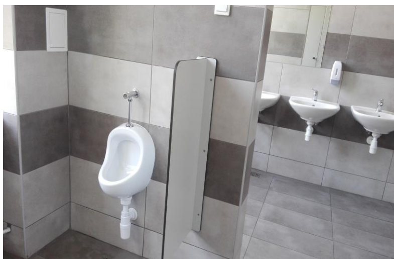
Pomieszczenie sanitarne dla chłopców w katowickiej szkole podstawowej (Źródło: Zdjęcie własne)
