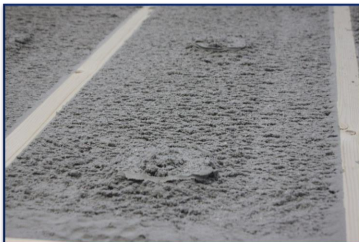
fot. 1 ocieplenie wełną celulozową
