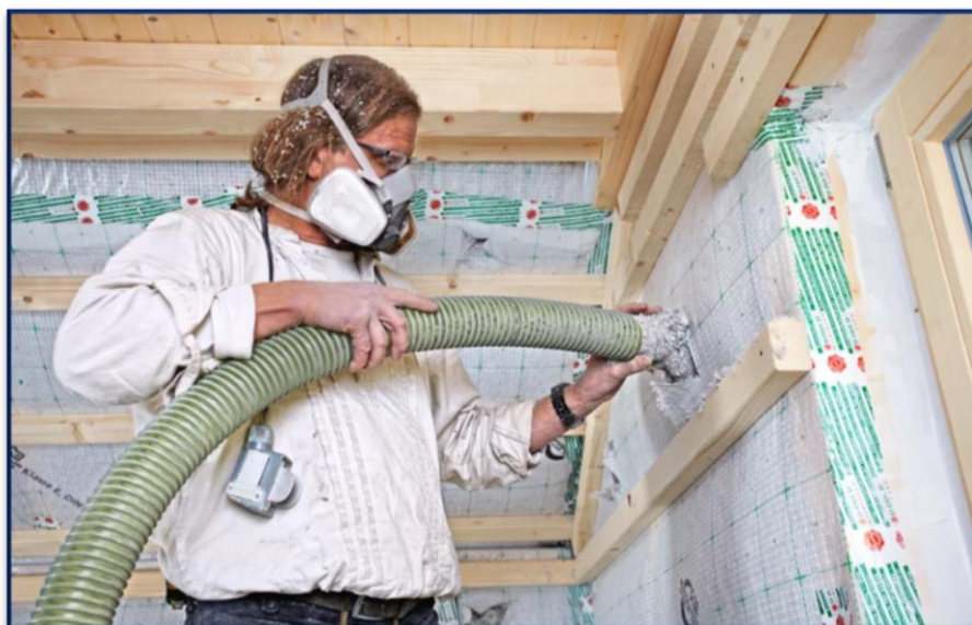
fot. 3 onet.pl: wdmuchiwanie włókien celulozowych
