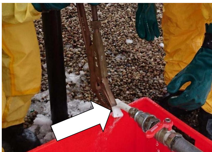
Fot. 33. Uszczelnianie rury narzędziami ręcznymi (klucz „żaba”). Źródło własne
