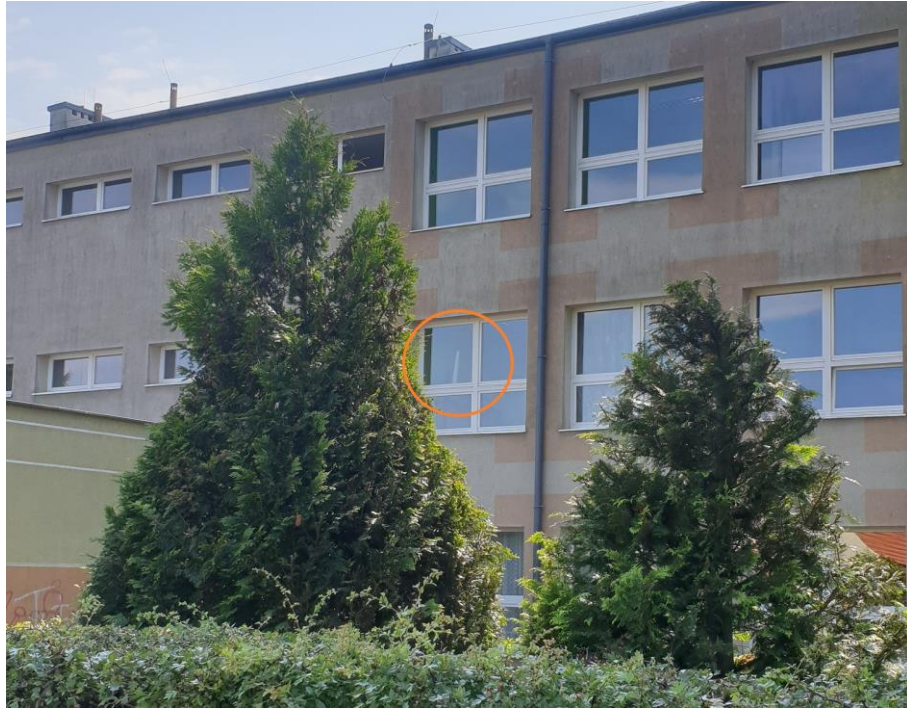
Rys. 3 Miejsce montażu pilotażowego SMS PEM – SP nr 3 w Słupsku – widok z zewnątrz
