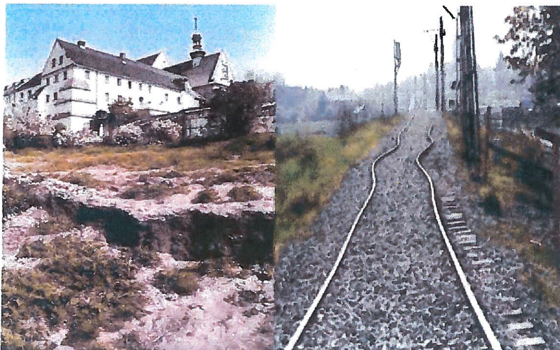
Rys.10i 11Szkoły na powierzchni w niecce osiadań w rejonie Klasztoru o.o. Franciszkanów-Reformatów i linii kolejowej
