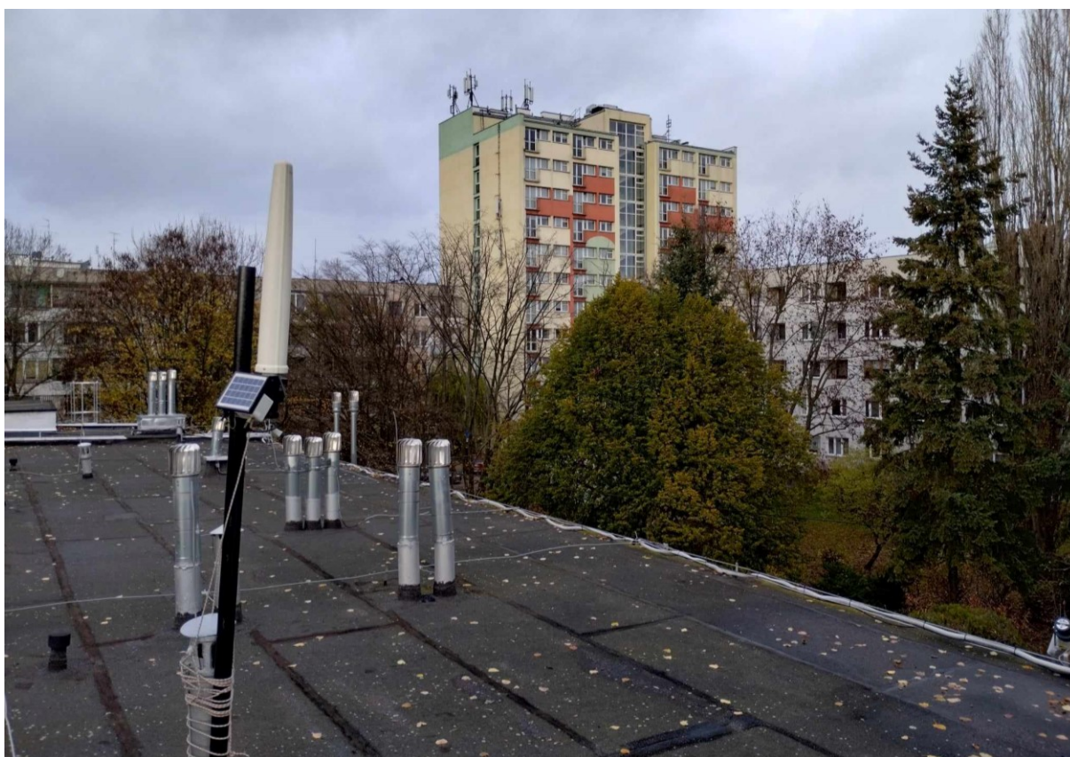
Rys. 2 Miejsce montażu SMS PEM – Liceum Ogólnokształcące AMIGO – widok na SBTk
