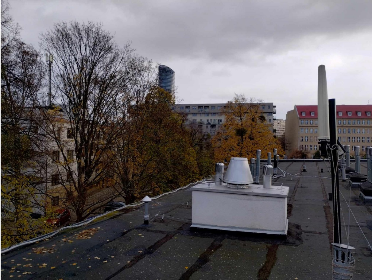
Rys. 3 Miejsce montażu SMS PEM – Liceum Ogólnokształcące AMIGO – widok na SBTk
