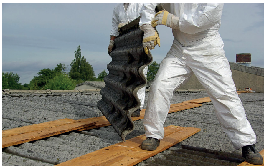
Prace przy usuwaniu eternitu zawierającego azbest
