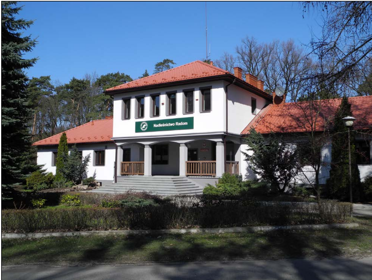
Fot. 1. Siedziba biura Nadleśnictwa Radom
