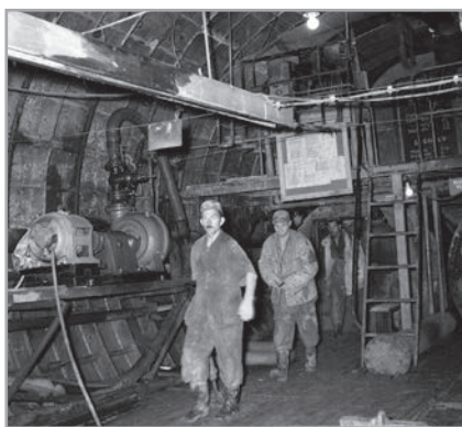
Robotnicy przy budowie metra w Warszawie, 1956. NAC
