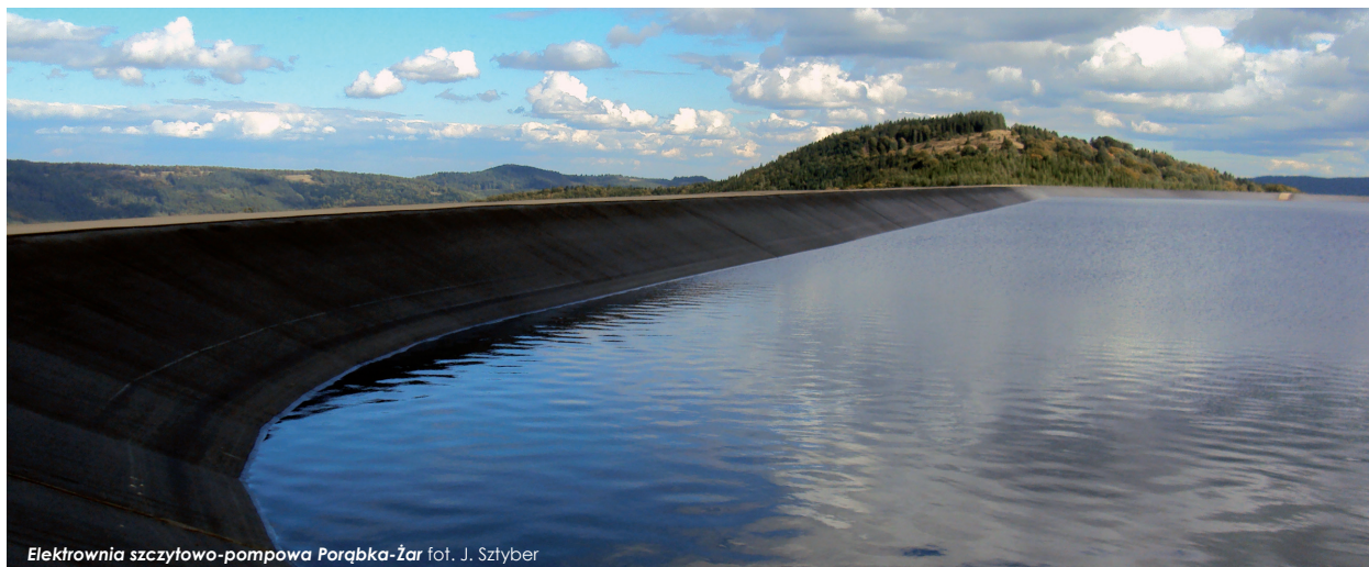
Elektrownia szczytowo-pompowa Porąbka-Żar fot. J. Sztzyber
