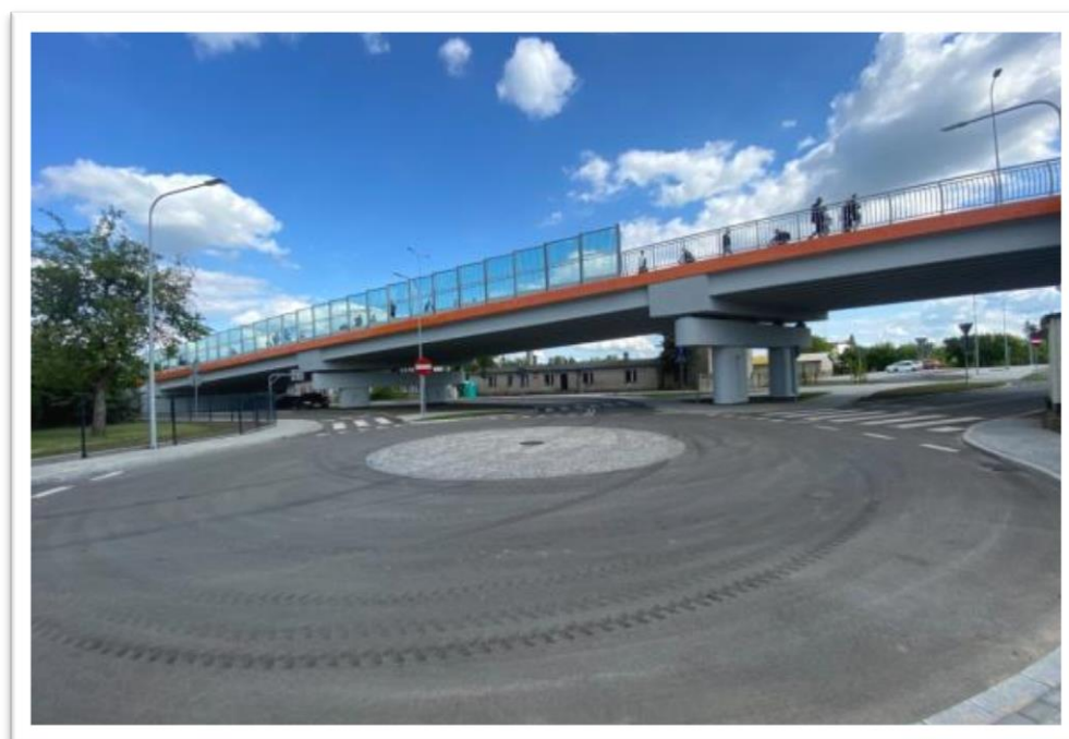
Rysunek 3 Wiadukt nad torami PKP w ciągu ulic Piłsudskiego i Zwierzynieckiej w Skierniewicach
