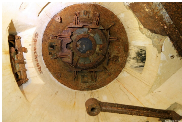
Fotografia 29. Schron bierny HO-08, wnętrze schronu z kopułą i stelazem siedziska obserwatora artyleryjskiego
