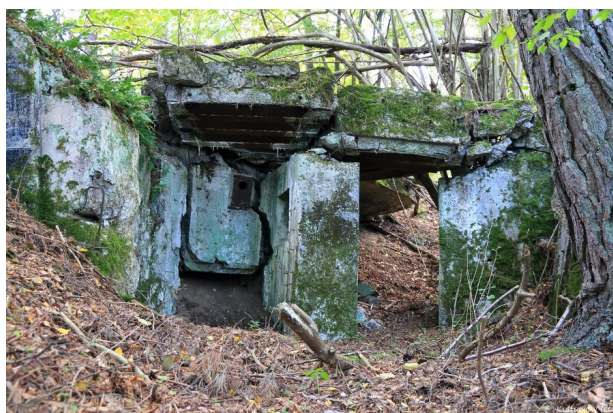
Fotografia 31. Schron bojowy KE-10 jednosektorowy, do prowadzenia ognia czołowego z jednego ciężkiego karabinu maszynowego, leśnictwo Czarnolesie, oddział 252
