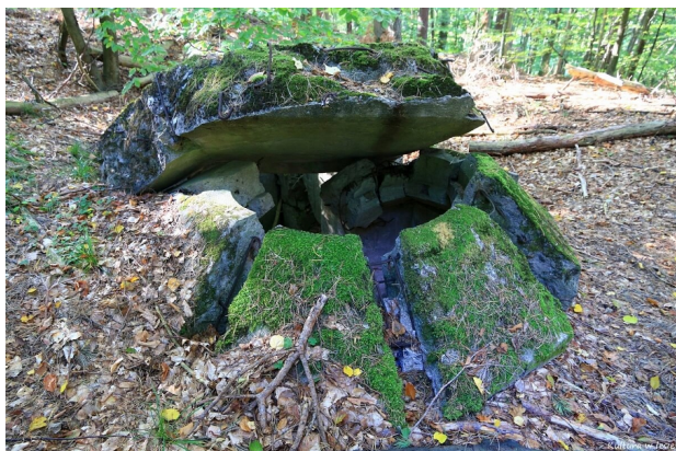
Fotografia 32. Schron bojowy KE-22 do prowadzenia ognia okrężnego z jednego karabinu maszynowego, typ Ringstand 58 c, leśnictwo Czarnolesie, oddział 186
