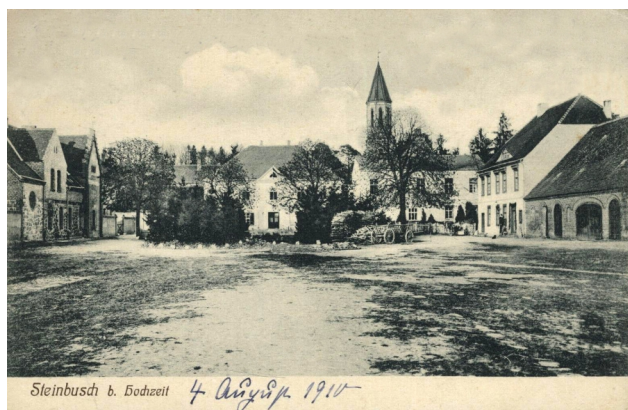
Fotografia 6. Widok na budynek nadleśnictwa (dawny dwór), budynki mieszkalne i gospodarcze oraz wieżę kościoła, pocztówka przedwojenna ( https://fotopolska.eu/ )
