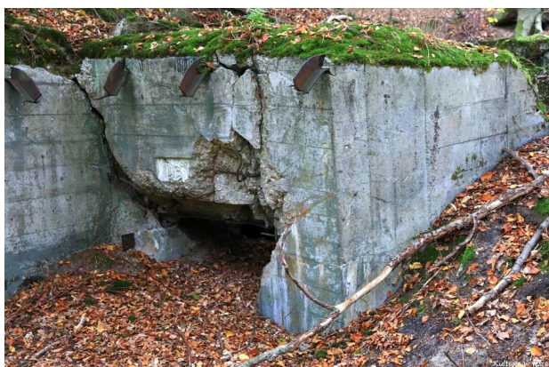
Fotografia 30. Schron bierny NEU-05 "Detlev" ze stanowiskiem dowodzenia, leśnictwo Żelaznica, oddział 123
