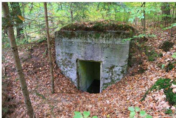
Fotografia 33. Schron bierny NEU-04 do ochrony ujęcia wody, leśnictwo Żelaznica, oddział 123
