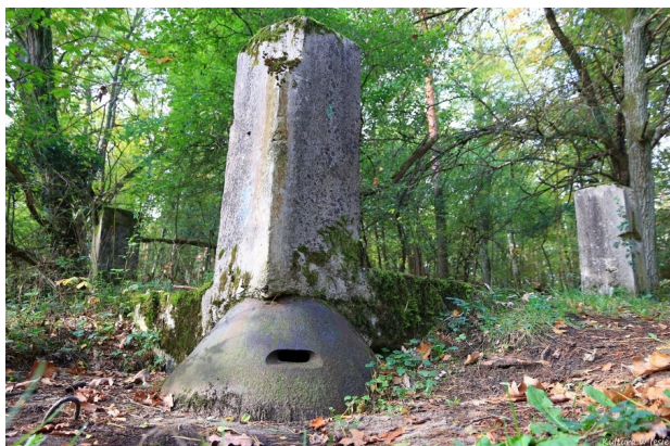
Fotografia 28. Schron HO-08 ze stanowiskiem obserwatora artylerii, z pancerną kopułą obserwacyjną typu 9P7, wbudowany w ogrodzenie cmentarza w Starym Osiecznie, leśnictwo Czarnolesie, oddział 162
