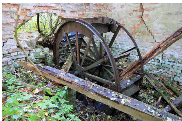
Fotografia 10. Koło wodne w dawnej stacji pomp wodociągu wiejskiego
